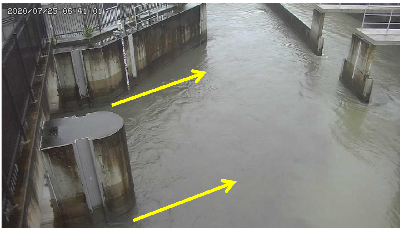
令和2年7月25日 6:41 川面水門 水路側
