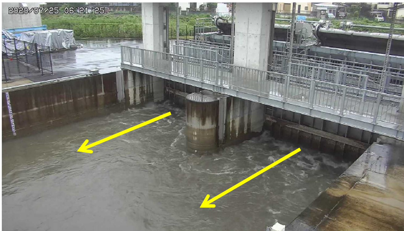
令和2年7月25日 6:21 佐間水門 水路側
