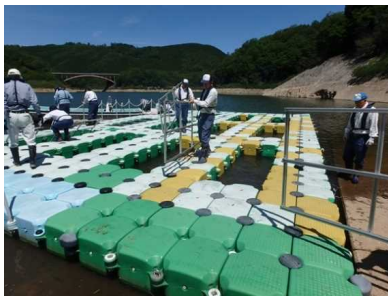
フロート整備
