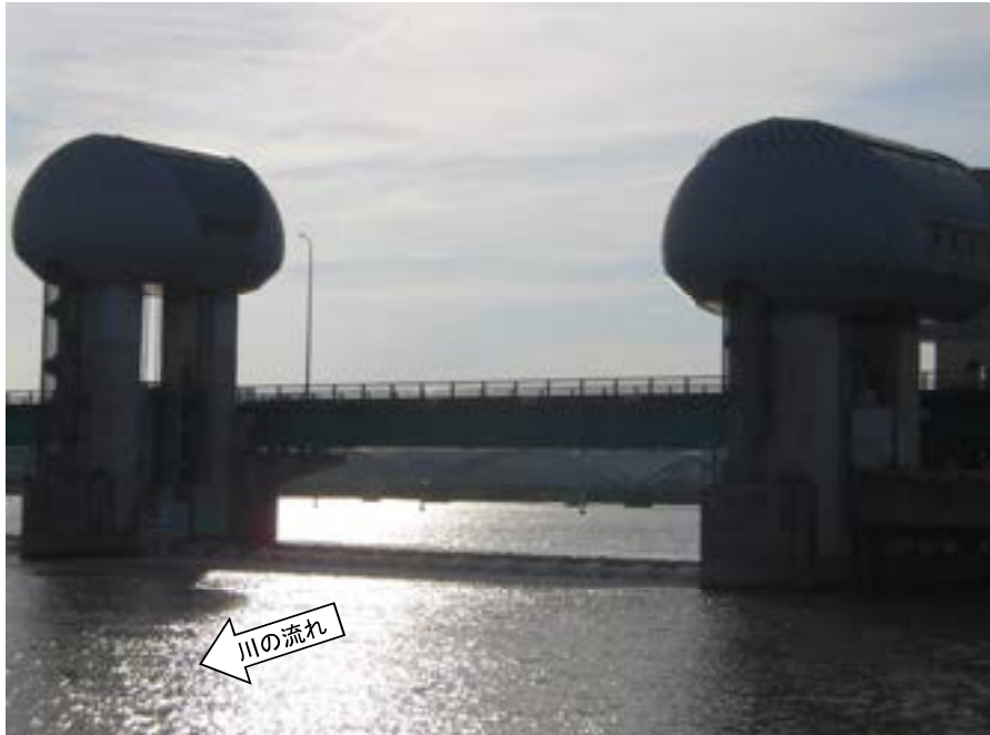
堰下流側 オーバーフロー操作に切り替え
