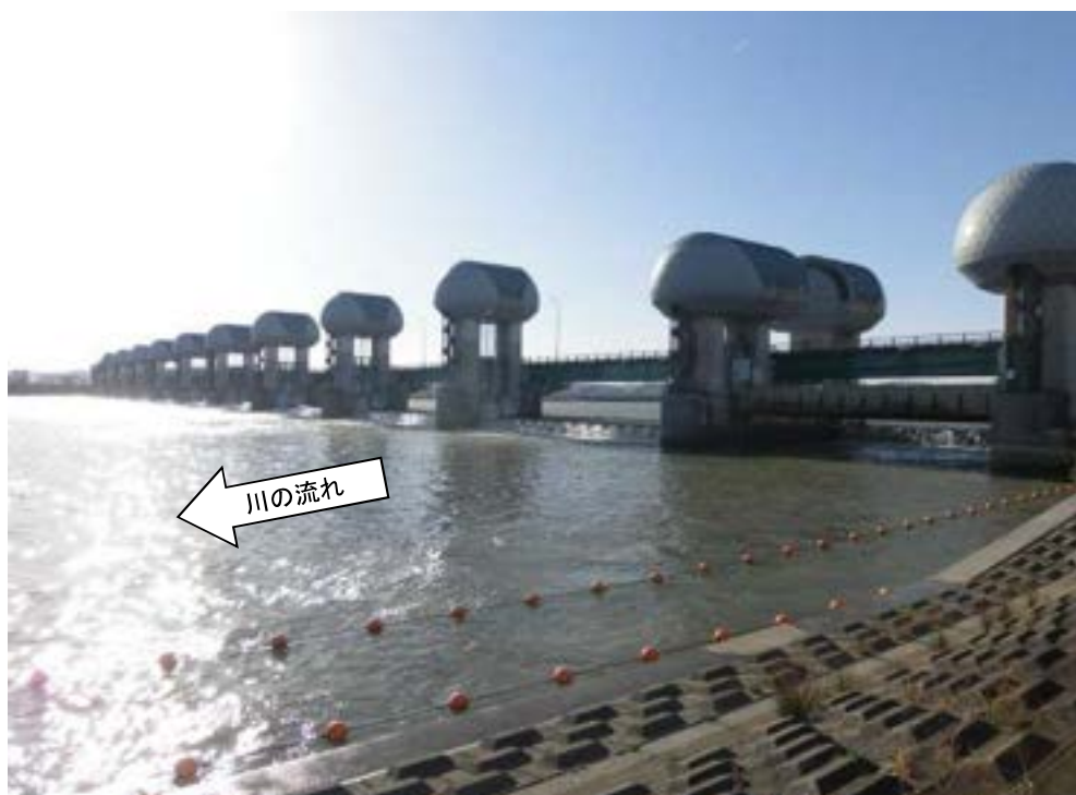
通常時の長良川河口堰(オーバーフロー操作による放流)
