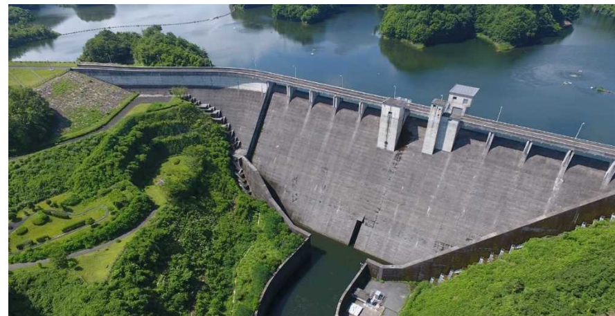
布目ダム全景
