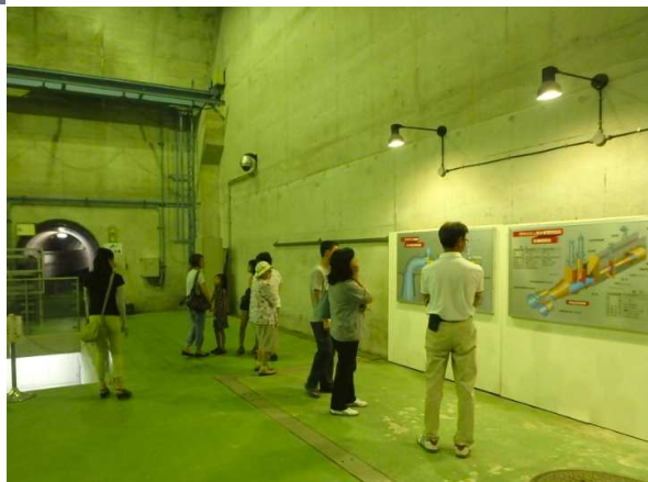
堤体内見学状況
