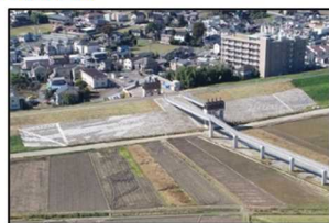
宗岡副水路(樋管部)
