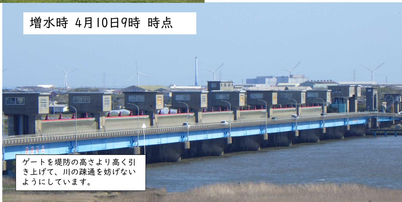
ゲートを堤防の高さより高く引き上げて、川の疎通を妨げないようにしています。
