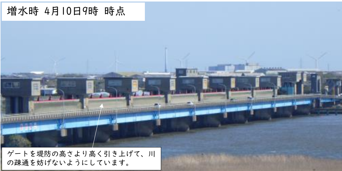
写真1 全門全開操作開始後の利根川河口堰 (右岸下流から堰を望む)
