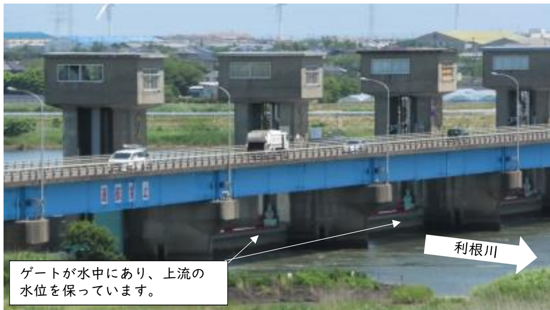
写真3 平常時の利根川河口堰
