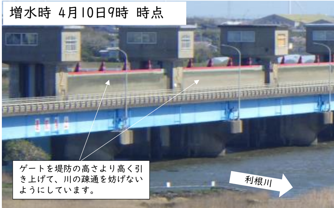
写真4 全門全開した利根川河口堰 (堤防高より高い位置にゲートを引き上げました。)
