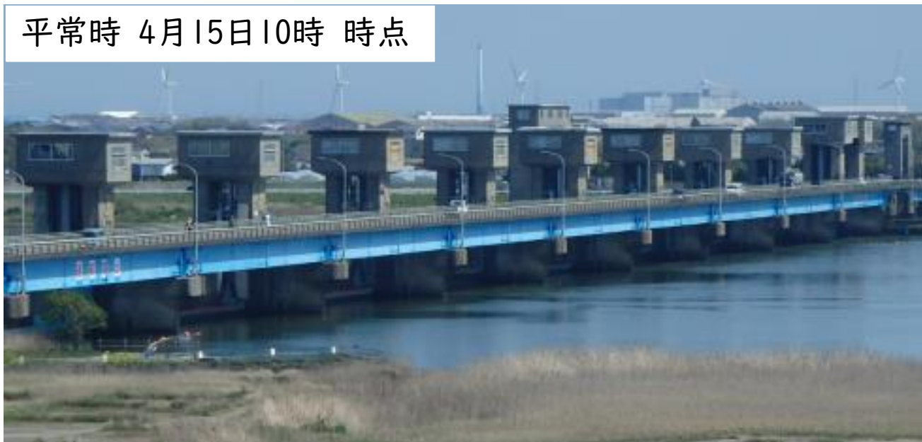
写真2 平常時操作移行後の利根川河口堰 (右岸下流から堰を望む)
