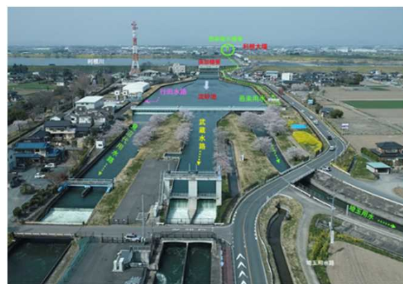
利根大堰から取水した水は用水路を通じて各地区に届けます
