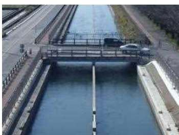
武蔵水路改築事業（平成4～27年度） 水路を二連化
