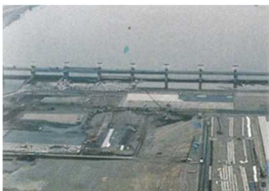
利根大堰施設緊急改築事業（平成4～9年度） 堰下流の護床工を改築
