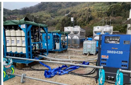
海水も浄水処理できる可搬式浄水装置
