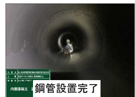
タ'クイル鑄鉄管設置完了
