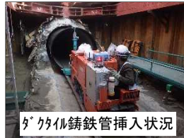
タ'クイル鑄鉄管搬入状況
