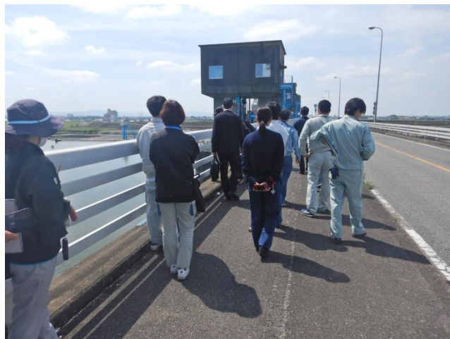
管理橋の確認状況
