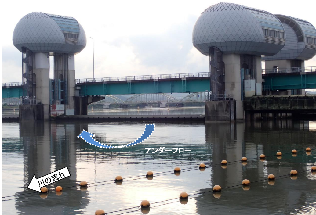
堰下流側 アンダーフロー操作に切り替え
