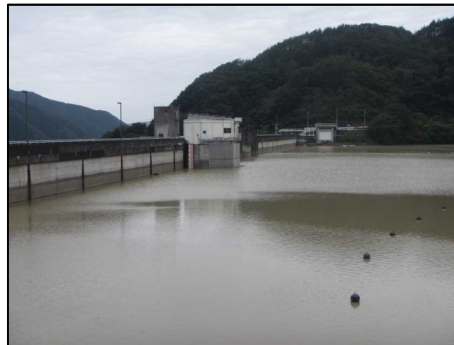
約 2,184万m 3 を貯留 (洪水調節後)
