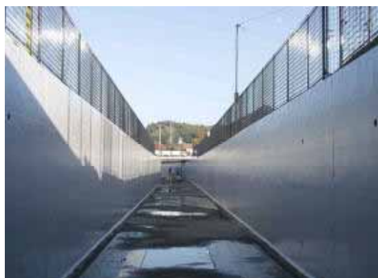
写真 - 3 炭素繊維シート被覆
