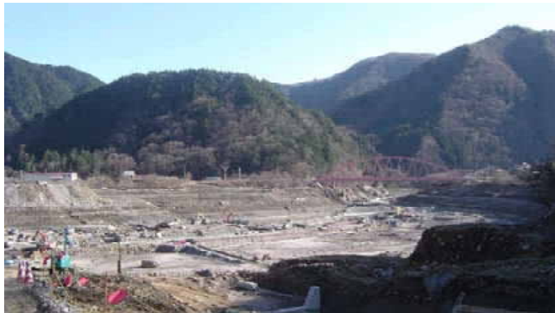
写真-5 牧尾ダム貯水池内土砂掘削・撤去
