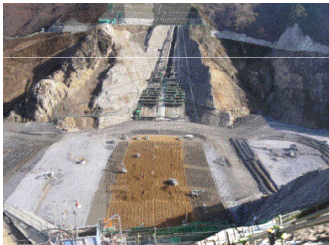
写真-1 徳山ダム本体施工状況
