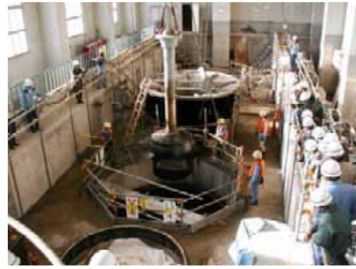
(既設ポンプ羽根車撤去状況)
