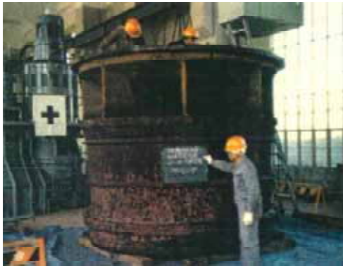
(既設ポンプケーシング撤去状況)
