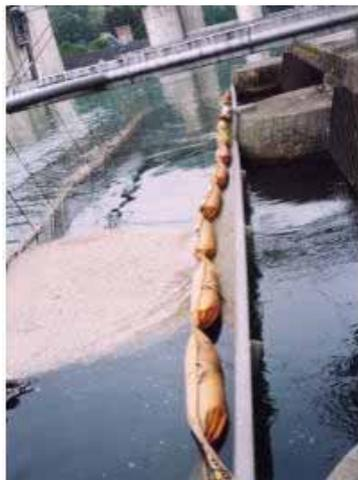
写真-2 綾戸取水口前面のオイルフェンス設置状況
