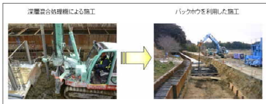
写真-1 水路暗渠地盤改良機種の見直し
