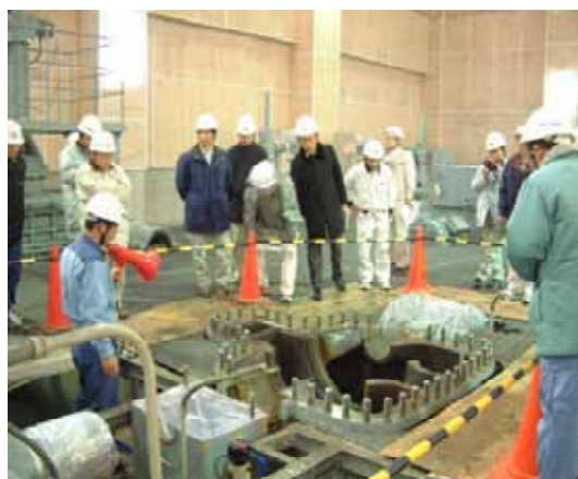
写真-2 ポンプ分解点検状況視察
