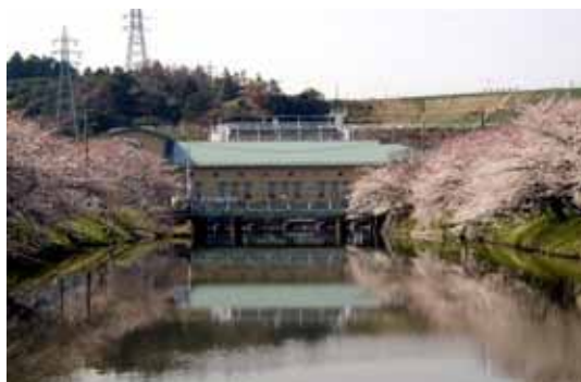
房総用水第一揚水機場
