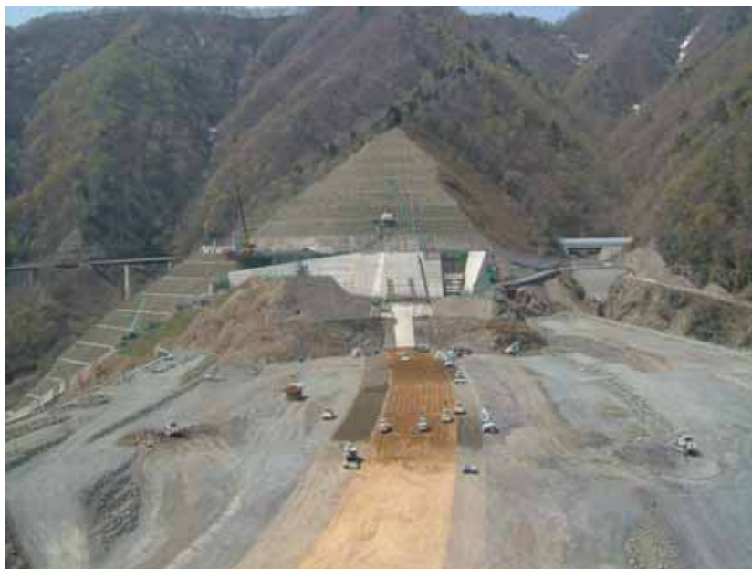
写真-1 徳山ダム本体施工状況
