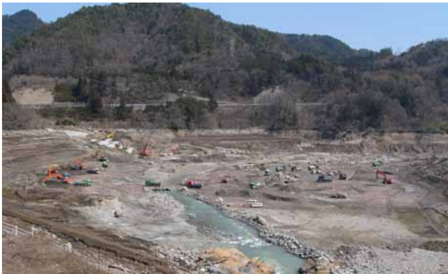
写真-4 牧尾ダム貯水池内土砂掘削・除去
