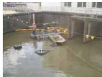
写真-4 底泥堆積物の除去
