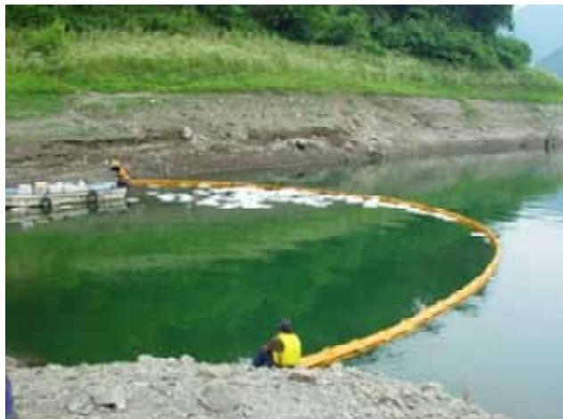
写真-1 オイルフェンス及びオイルマットを使用した回収作業
