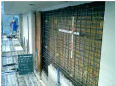
施工状況(壁配筋状況)
