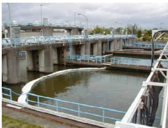
写真-3 沈砂池のオイルフェンス設置状況
