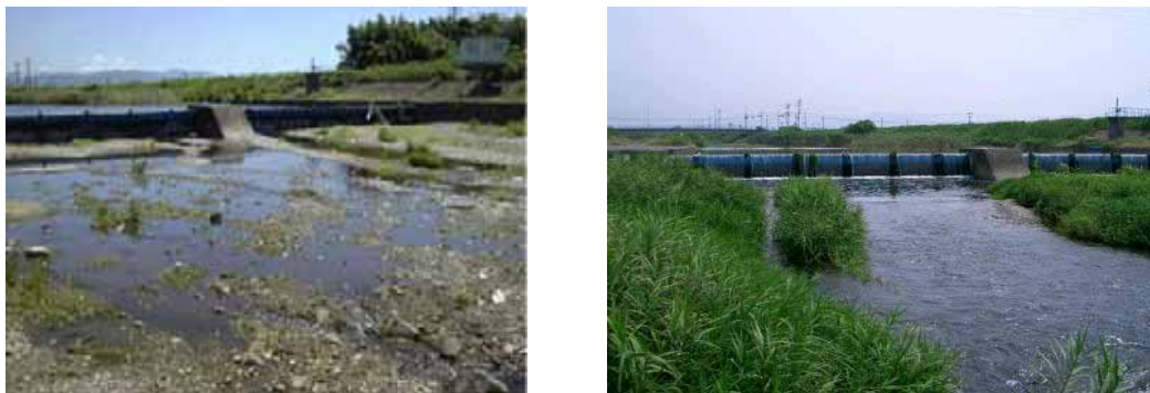
瀬切れになっている時の状況(平成14年8月) 運用期間中の流況(平成16年7月)
