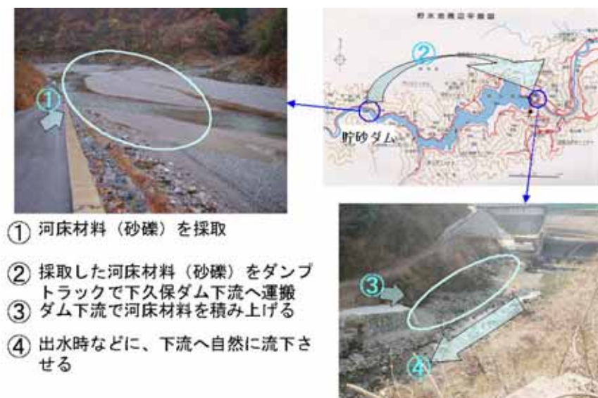
図-1 土砂の供給方法（下久保ダム）
