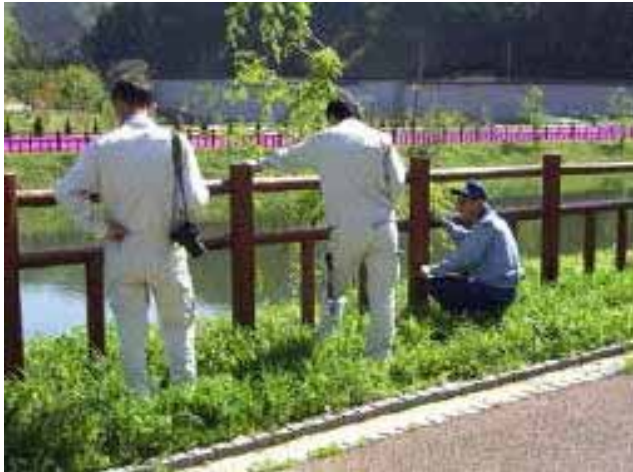
写真-1 施設の安全点検を実施している状況 (室生ダム)
