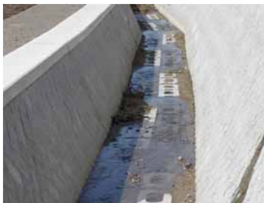
写真-6 自然環境に配慮した護床ブロックの配置
