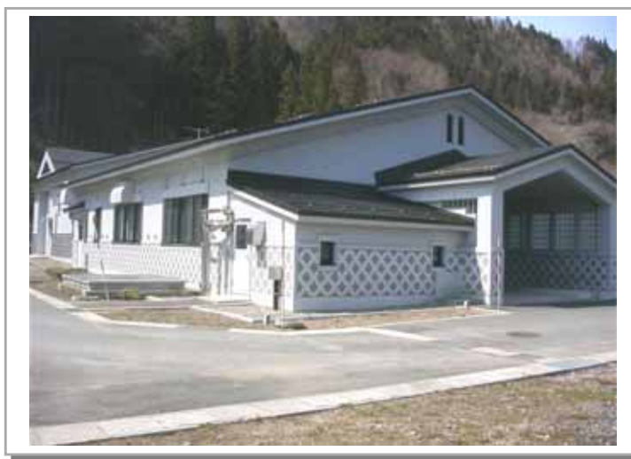
写真-2 片品村下水処理場（戸倉ダム）
