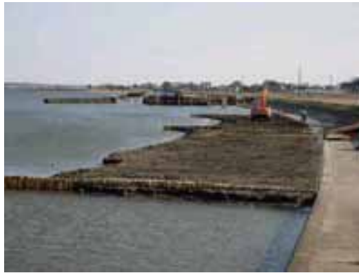
写真-2 前浜造成の施工状況
