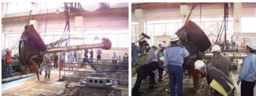
写真-3 ポンプ解体現場見学状況
