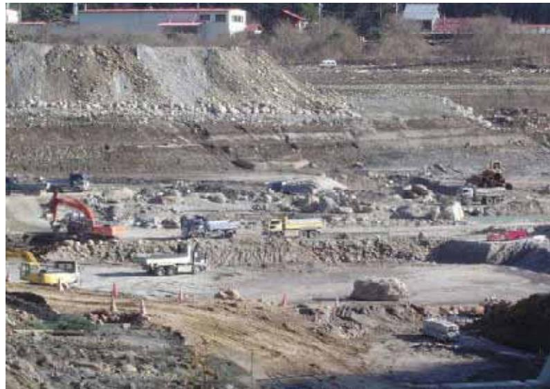
写真-5 牧尾ダム貯水池内土砂掘削・撤去
