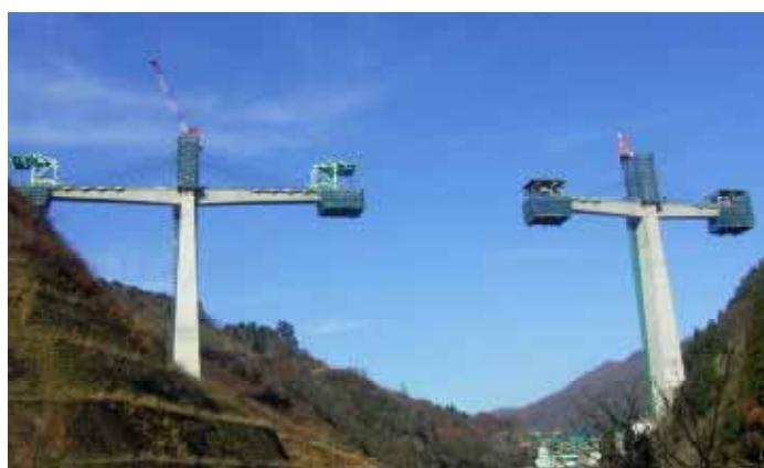
写真-2 徳山ダムの貯水池横断橋の施工状況
