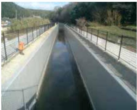
幹線水路開水路（補強施工後）
