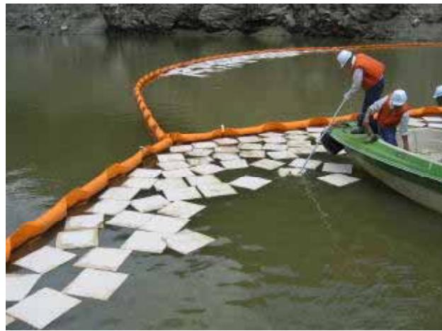
写真-4 オイルフェンス設置及び吸着マットによる回収作業状況
