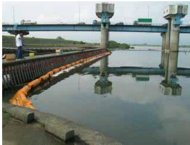
写真-5 取水口のオイルフェンス設置状況
