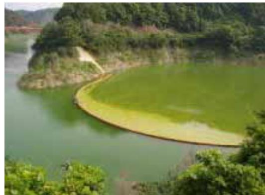
写真-2 拡散防止を目的としたフェンスの設置（一庫ダム）
