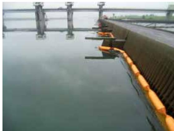
写真-3 取水口のオイルフェンス設置状況
