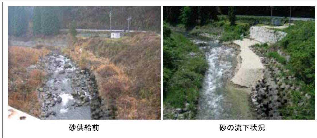
写真-1 ダム堆砂を下流河川の砂供給に有効利用
