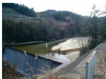
貯留ダムの掘削前
