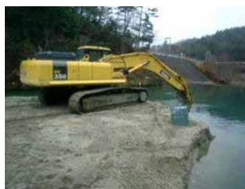
貯留ダムでの土砂採取状況
