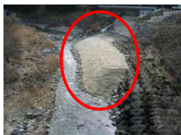
土砂投入状況
