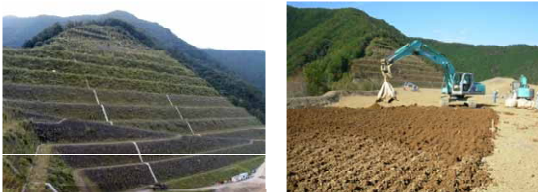
写真－１ 左：原石山法面 自然植生の復元状況、右：保存表土の張り付け状況
