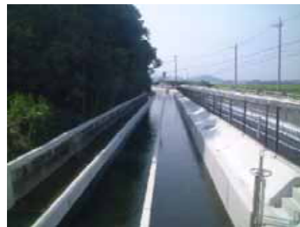
写真－ 5 水路フェンスの設置 (豊川用水総合事業部)
