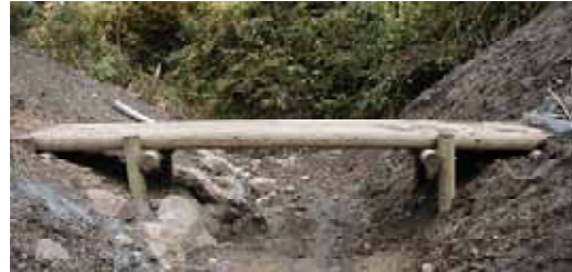
間伐材を用いた丸木橋の設置 (丹生ダム建設所)
