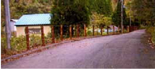
間伐材を用いた立ち入り防止柵の設置 (丹生ダム建設所)
