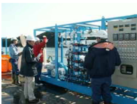
写真－４ 装置運転状況
