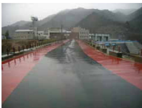
写真-1 矢木沢ダムわきダム周辺整備 (沼田総合管理所)
