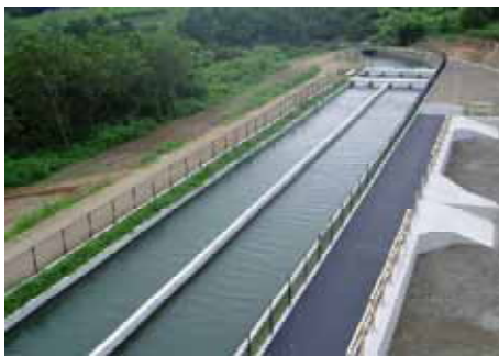
写真－ 4 水路フェンスの設置 (群馬用水総合事業所)
