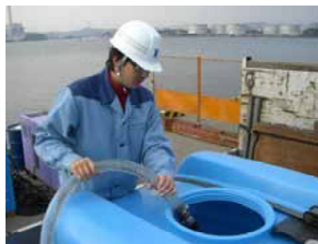
写真－５ 給水タンクへの注水状況
