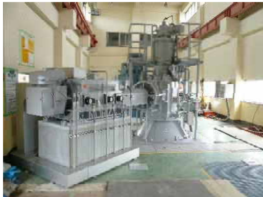
写真 - 4 酒直機場（ポンプ施設の改築）
