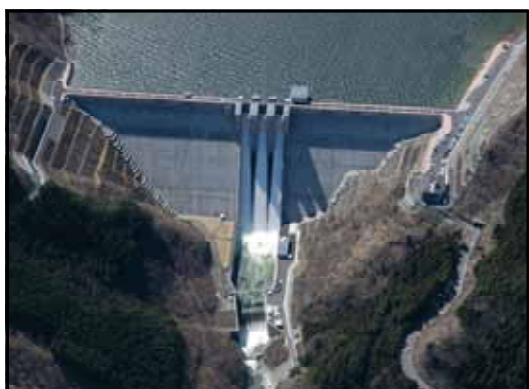
写真 - 3 滝沢ダム試験放流状況
