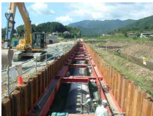
併設水路工事状況(開削施工)
