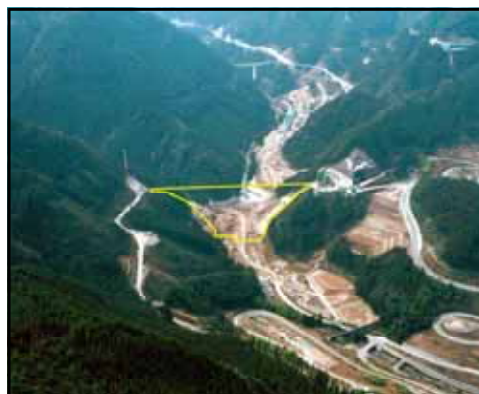
写真 - 6 思川開発 (付替県道工事)
