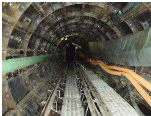
併設水路工事状況(シールド工)
