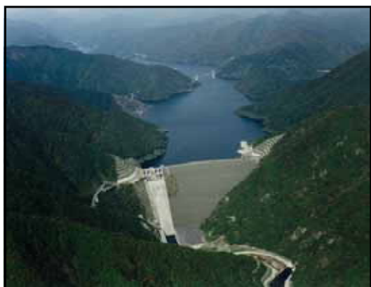
写真 - 1 徳山ダムの試験放流状況
