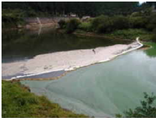
写真 - 3 ダム湖のオイルフェンス設置状況
