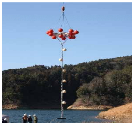
写真 - 6 曝気循環設備設置 状況(阿木川ダム)
