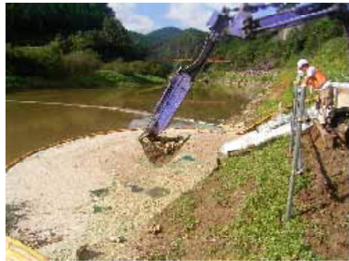
写真 - 4 油回収実施状況
