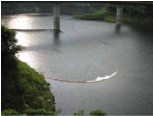
写真 - 1 オイルフェンスの設置状況
