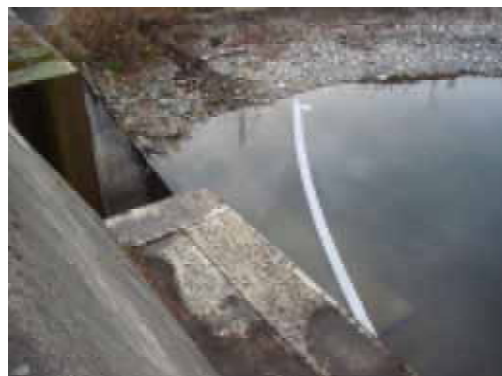
写真 - 5 オイルフェンス、オイルマットの設置状況
