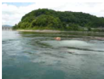
写真 - 7 浅層曝気設備の試験運用 (一庫ダム)
