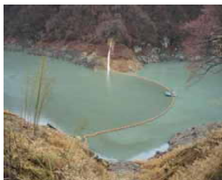
写真 - 2 分画フェンス設置状況（下久保ダム）
