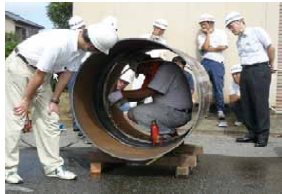
写真 - 4 継手補強材設置訓練（千葉）
