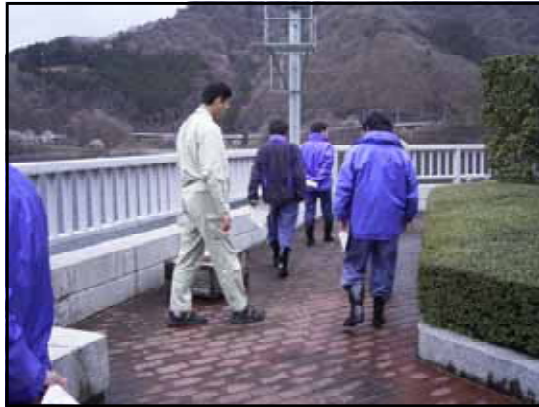
写真 - 1 施設安全点検の状況
