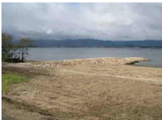
写真 - 13 湖岸の浸食対策(琵琶湖開発)
