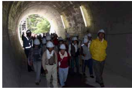
写真 - 4 仮排水路トンネルウォーク （大山ダム）
