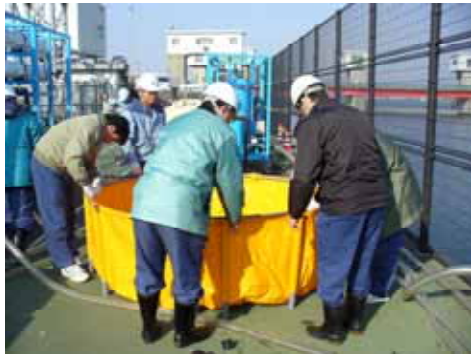
装置設営状況
