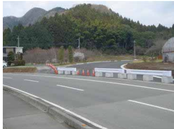
写真 - 4 現県道からの取付部
