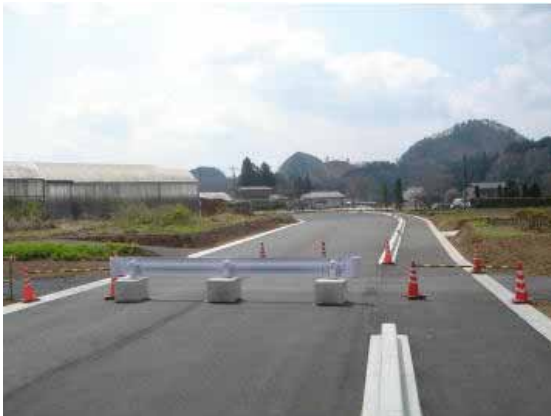
写真 - 3 付替県道の一部完成
