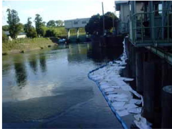
写真 - 2 糠田排水機場のオイルフェンス設置状況
