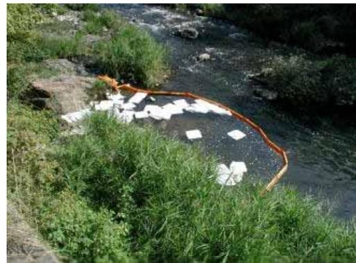
写真 - 6 河川流出部のオイルフェンス設置状況
