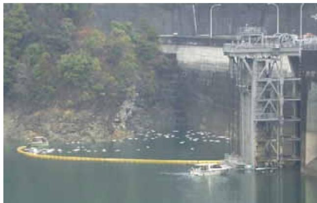
写真 - 1 オイルフェンス、オイルマットを使用した回収作業
