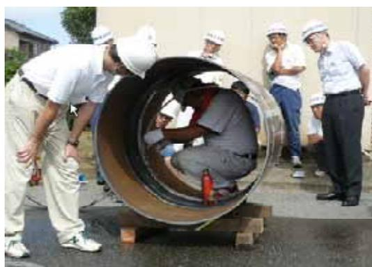
写真 - 4 継手補強材設置訓練（千葉用水）
