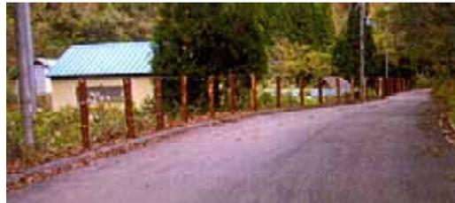
写真 - 4 間伐材を用いた立ち入り防止柵の設置
