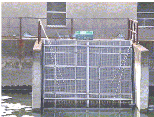
写真-1 フィルター材設置後
