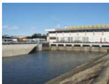
写真－5 大和田排水機場運転状況 (千葉用水総合事業所)
