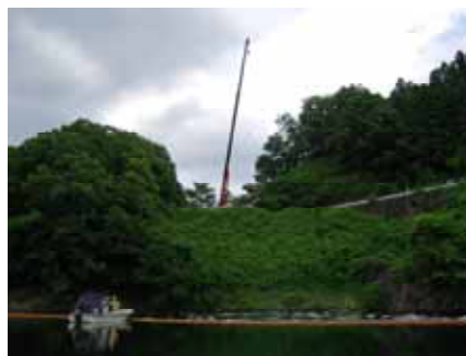
写真-4 車両引き上げ状況
