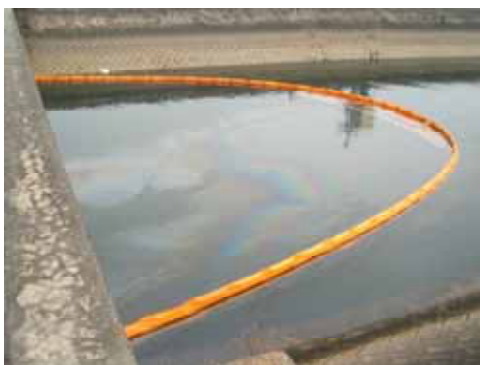
写真-9 オイルフェンス設置状況
