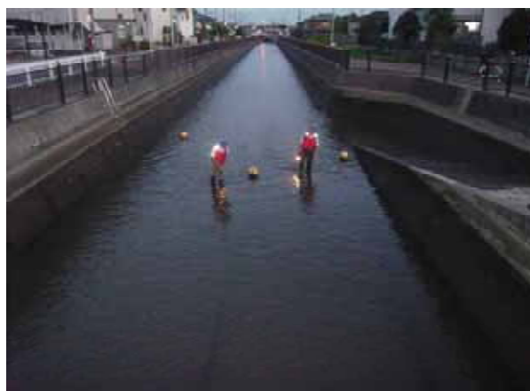
写真-5 水路内調査状況
