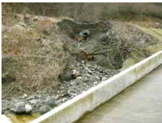
写真－1 徳山ダム貯水池斜面被災状況及び補修状況
