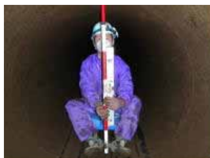
写真－４ 管内面調査状況
