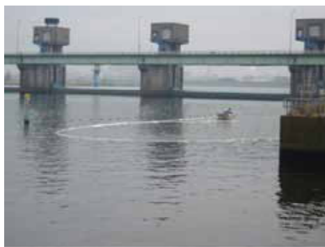
写真-10 堰下流での吸着状況
