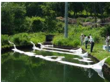
写真－1 オイルフェンス設置状況
