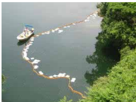
写真-3 オイルフェンス・マット設置状況
