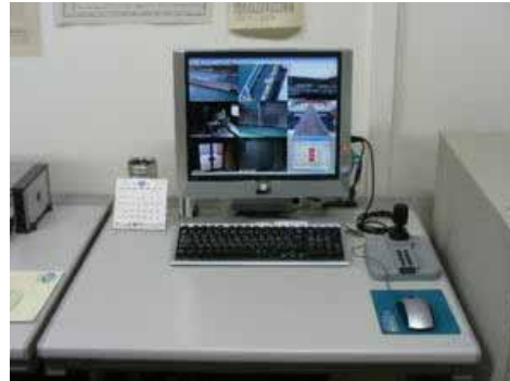
写真－２ 監視カメラからの映像（群馬用水）
