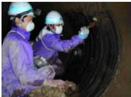
写真－３ 管内面調査状況
