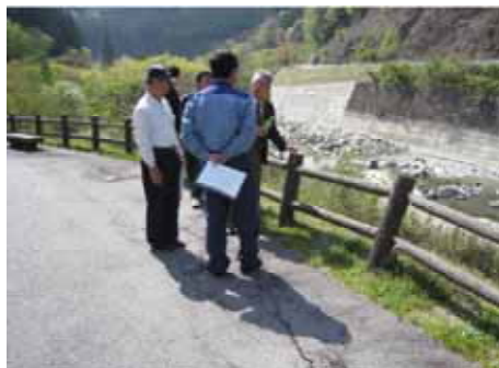
写真－４ 一般利用施設点検状況（岩屋ダム）
