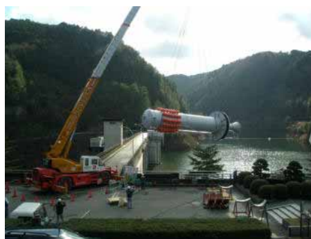
写真－2 深層曝気設備設置状況 (室生ダム)
