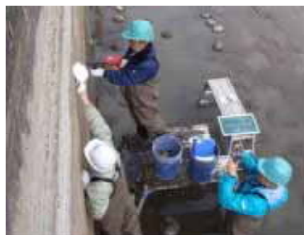
写真－２ 中性化試験（ドリル法）
