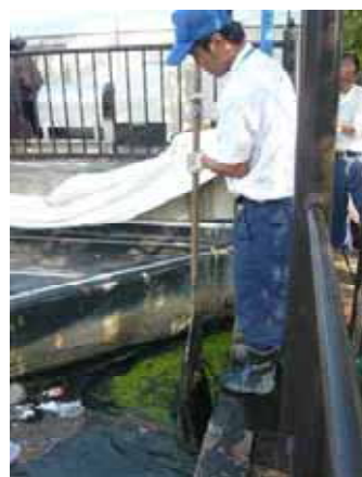
写真-6 油類引き上げ状況
