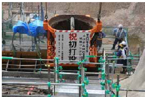
写真－２ コンクリート初打設（大山ダム）
