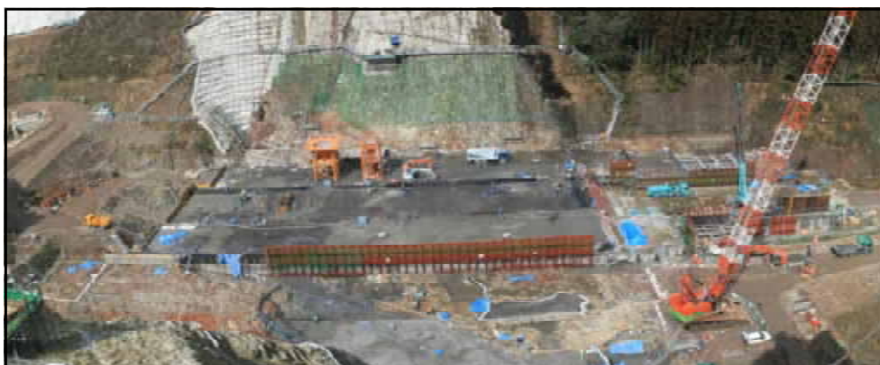
写真－１ ダム工事状況（大山ダム）
