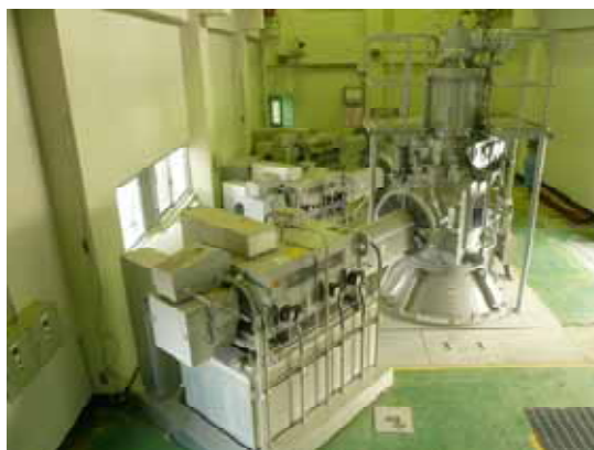
改築したポンプ設備（酒直機場）
