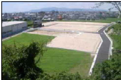
写真－３ 集団移転地（小石原川ダム）
