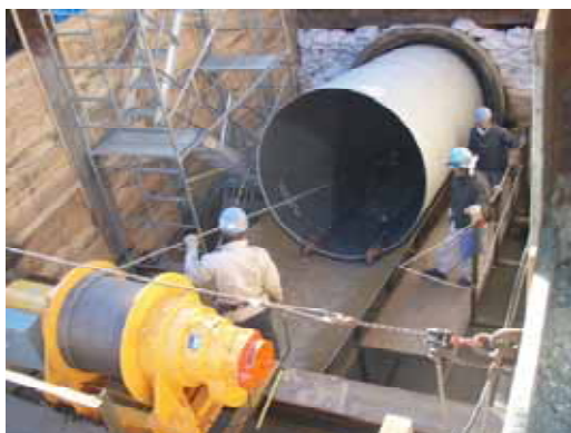
吾妻川サイホン既設管補強工事の状況
