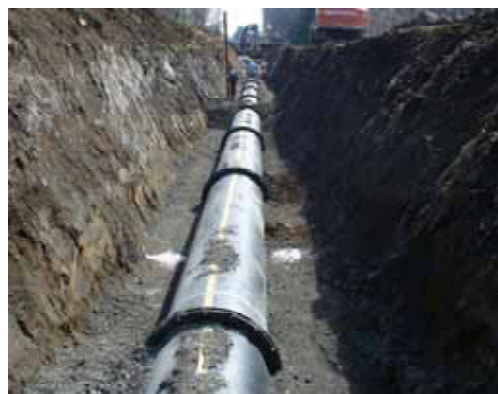
東部3号支線改築工事の状況
