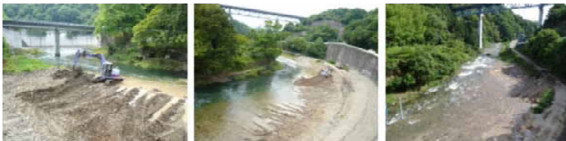
写真－２ 一庫ダム 土砂掃流、フラッシュ放流の状況
