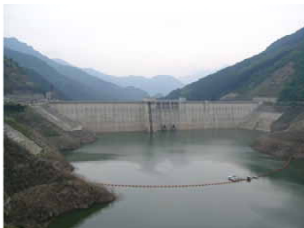
写真－5 滝沢ダム試験湛水状況（平成21年5月）
