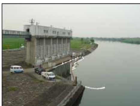
写真-11 オイルマット設置状況
