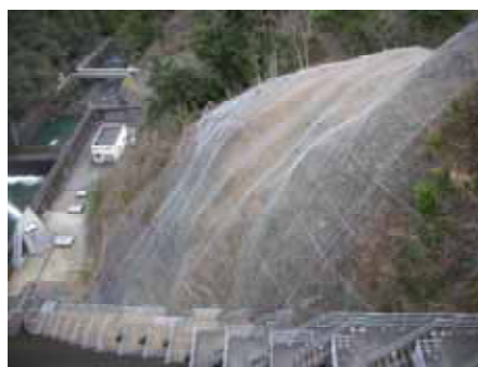
写真－２ 江川ダム補修状況
