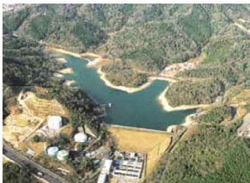
写真－２ 駒場調整池 (豊川用水総合事業部)
