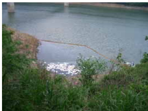
写真－１ オイルフェンス・マット設置状況
