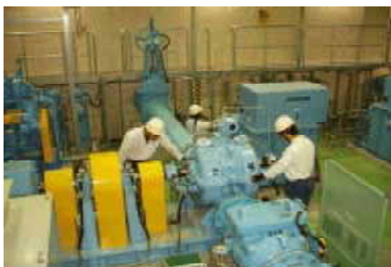
写真－4 宝山湖揚水場ポンプ室
