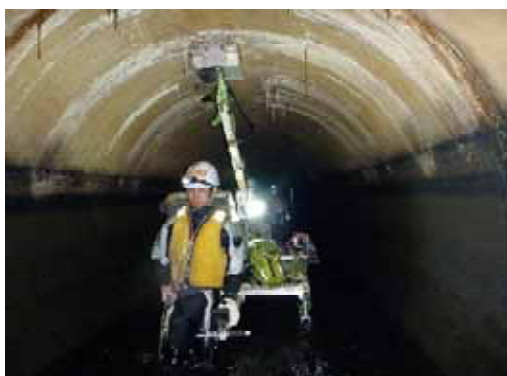
写真－1 トンネル内空洞調査
