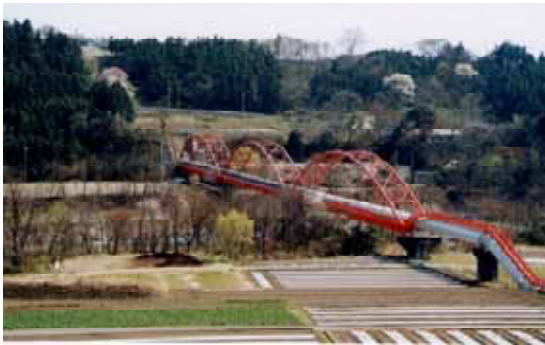
写真－７ 水管橋全景
