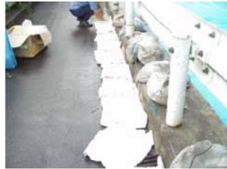
写真－４ 薬品流出防止対策状況
