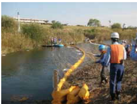
写真－９ オイルフェンス設置訓練
