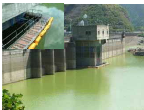
写真－4 取水塔周りに設置された濁水防止膜（江川ダム）
