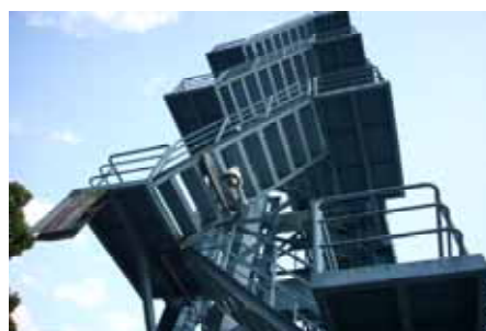
写真-4 左岸監視カメラ
