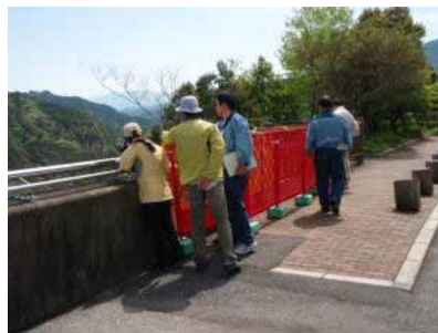
写真－４ 一般利用施設点検状況（早明浦ダム）
