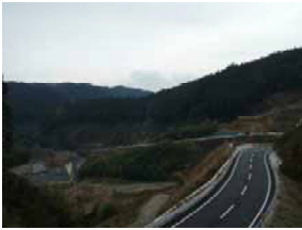
写真－１ 付替県道供用開始（川上ダム）
