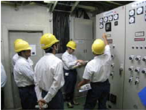
写真－６ 予備発電設備操作訓練状況
