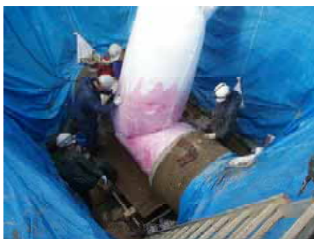
管更生工法による既設水路改築状況
