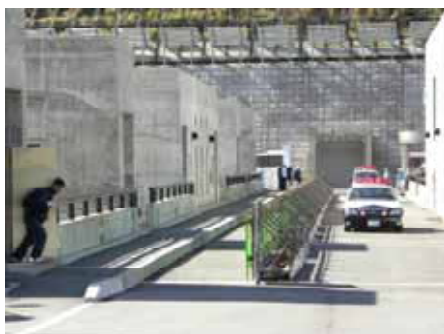
写真－１ 通報により警察が到着 (徳山ダム)
