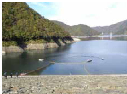
写真－３ 毒物が投入された周囲 にオイルフェンス設置
