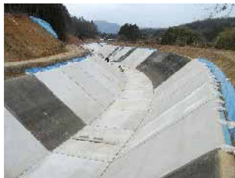
既設水路（東部幹線水路）の改築
