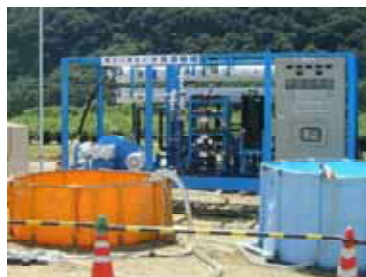
装置の設置完了
