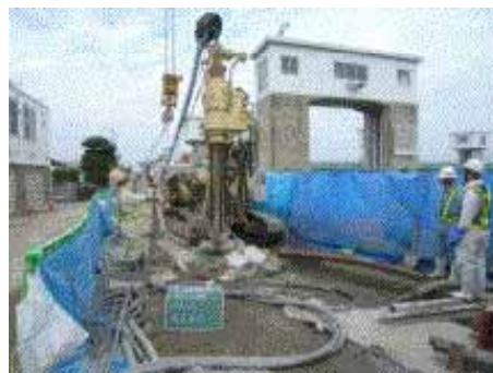
写真－1 耐震補強工事の状況
