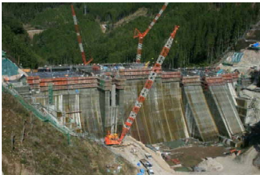
写真－２ ダムの工事状況（大山ダム）
