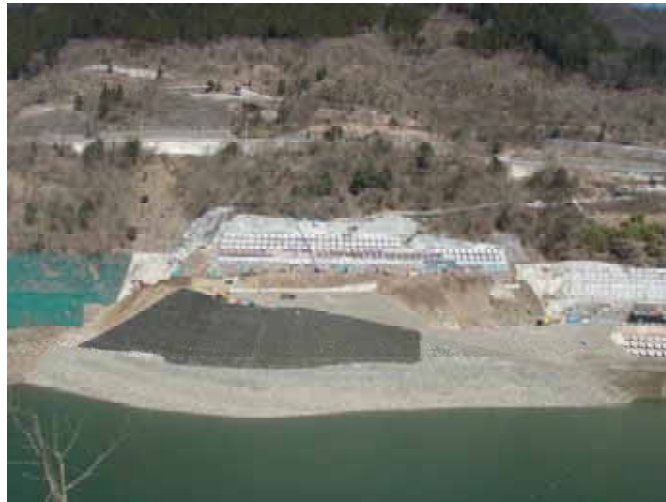
写真－１ 斜面对策の工事状況（滝沢ダム）
