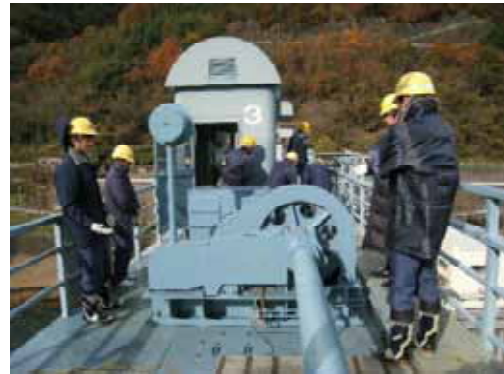
写真－７ 予備動力を用いたゲート操作訓練
