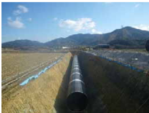
併設水路（東部幹線水路）工事
