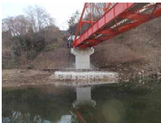
写真－２ 耐震補強した吾妻川水管橋 （群馬用水施設緊急改築事業）
