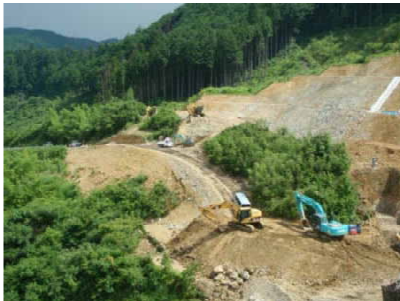
写真－６ 付替県道の工事状況（川上ダム）
