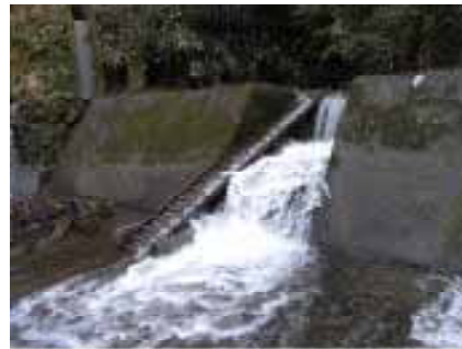
写真-6 試験的に設置した オオサンショウウオ道
