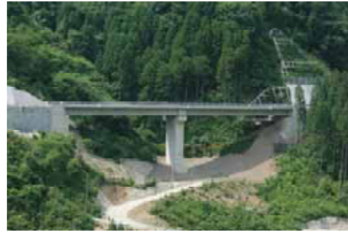
写真－２ 付替県道工事状況（大山ダム）
