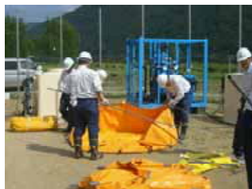
職員による設置作業
