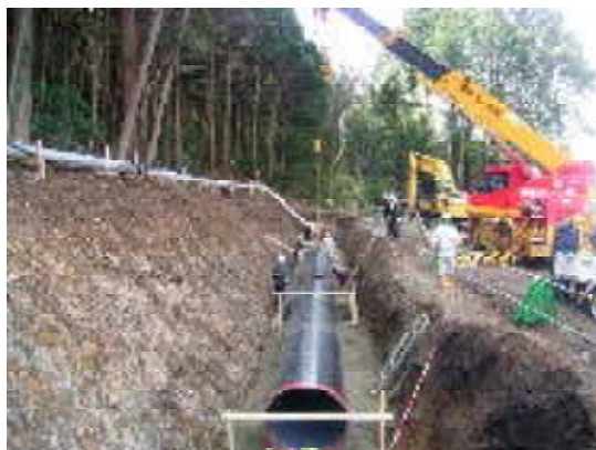
管水路（左岸幹線水路）の更新 写真－４ 木曽川右岸施設緊急改築事業
