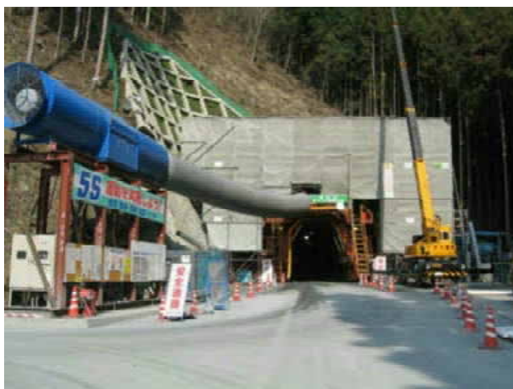
写真－４ 付替県道４号トンネルの工事状況（思川開発）
