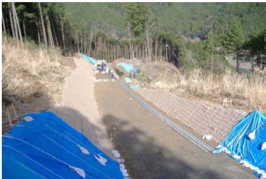
写真－7 付替国道の工事状況（小石原川ダム）
