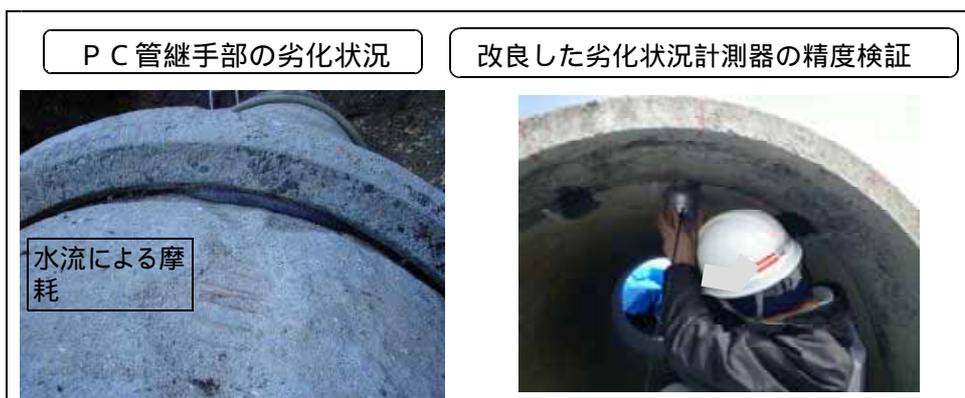
写真 - 1 P C 管継手部の劣化調査
