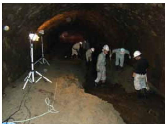
写真 - 3 白川取水工内土砂排除
