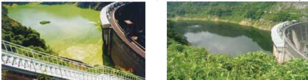
写真 - 2 浅層曝気循環設備の運用効果（高山ダム）
