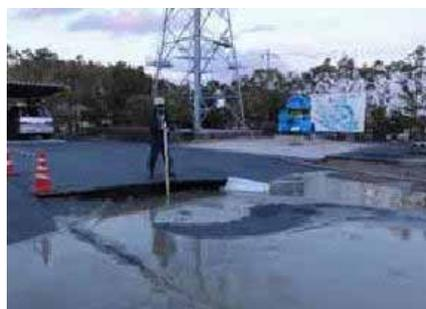
写真 - 6 揚水機場構内沈下状況
