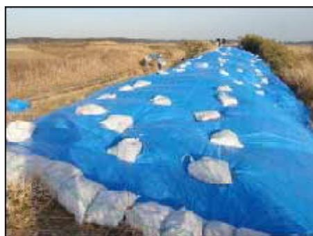
写真 - 3 堤防被災状況と保全対策状況（印旛沼）
