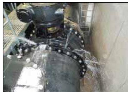
写真 - 4 分水工漏水状況
