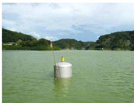
写真 - 10 浅層曝気循環設備の設置状況（一庫ダムの例）
