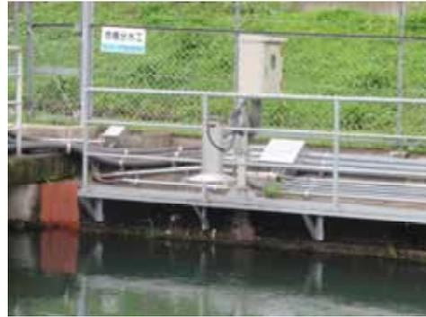
写真 - 1 2 油面検知器設置状況
