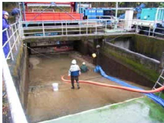
写真 - 4 神測量水部土砂吸引
