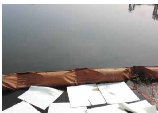
写真－１０ オイルマット設置状況
