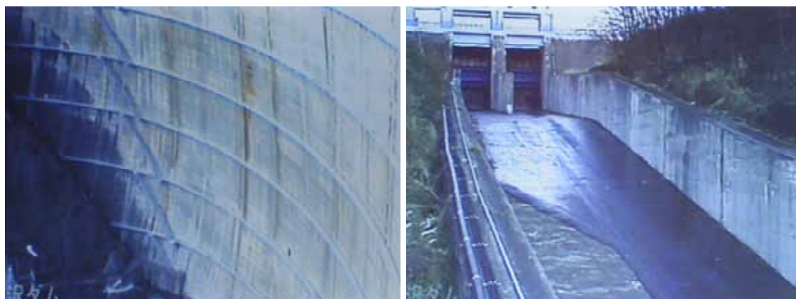
ダム堤体の監視
