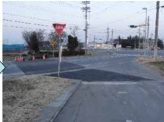
写真－１ 災害復旧の状況（道路横断部の沈下を原型復旧）〔霞ヶ浦揚水施設〕
