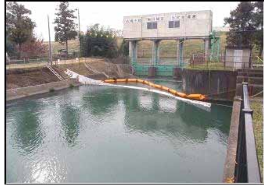
写真-6 オイルフェンス・マット設置状況
