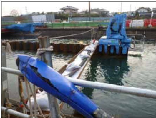
写真-7 渡り栈橋設置状況
