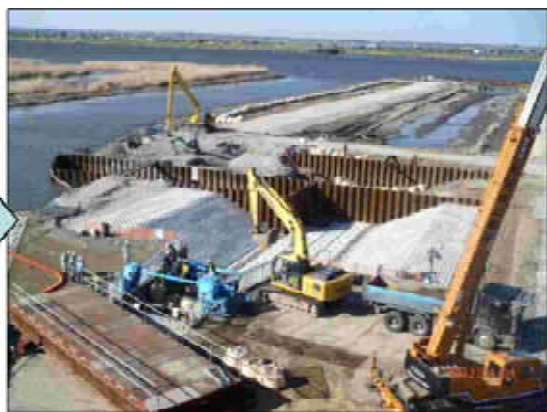
写真－２ 災害復旧の状況（取水工の沈下した開水路及び損壊した翼壁工の原型復旧） 〔北総東部用水施設〕
