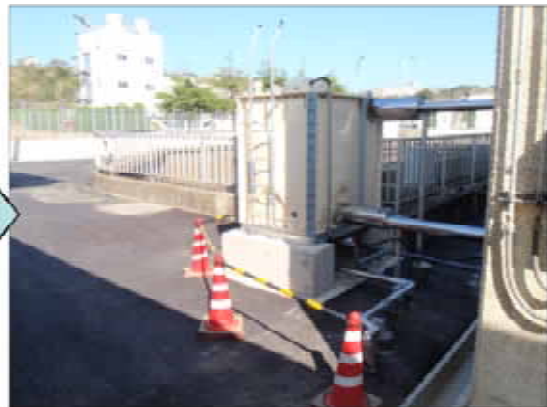
写真－３ 災害復旧の状況（揚水機も沈下した冷却タンクの原型復旧）〔東総用水施設〕
