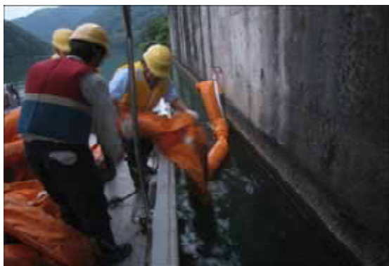
写真－１ オイルフェンス設置作業状況
