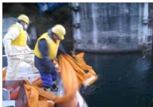
写真－４ オイルフェンス設置状況
