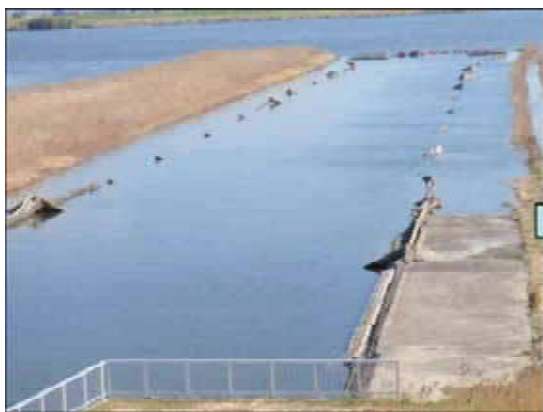
写真－２ 災害復旧の状況（取水工の沈下した開水路及び損壊した翼壁工の原型復旧） 〔北総東部用水施設〕
