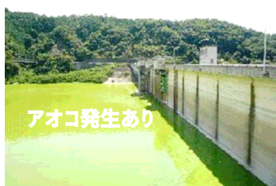
写真－９ 設備稼働前の状況 (一庫ダム：平成22年８月)
