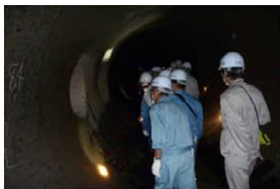
(香川用水) 関係機関を対象とした見学会 (琴平サイホン内部)
