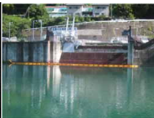
写真－２ オイルフェンス設置状況
