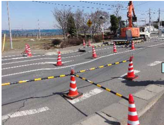
写真－１ 災害復旧の状況（道路横断部の沈下を原型復旧）〔霞ヶ浦揚水施設〕
