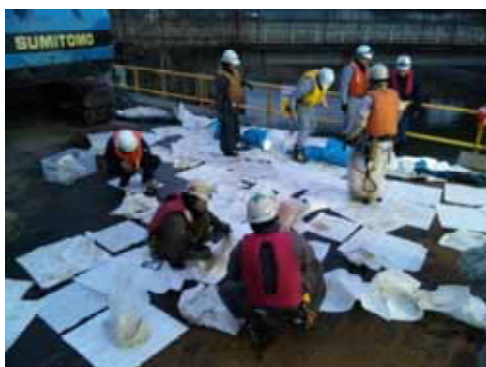
写真－９ オイルフェンス設置状況
