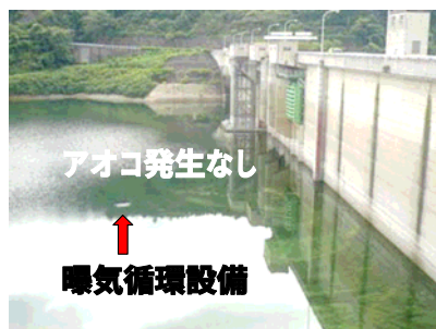
写真－１０ 設備稼働中の状況 (一庫ダム：平成23年８月)
