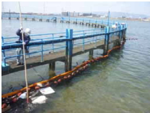
写真-13 オイルフェンス設置状況
