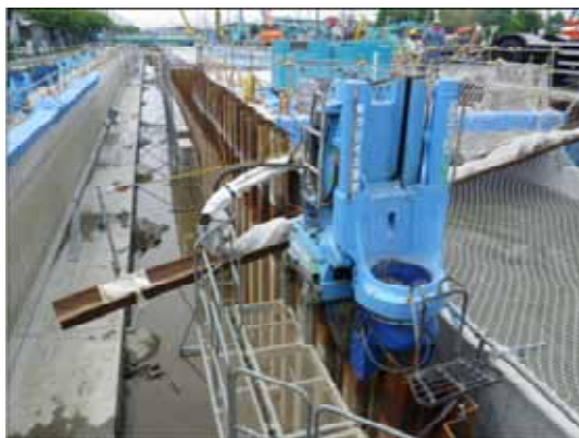
写真－１１ 油圧ホースの被覆状況
