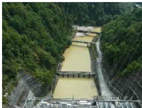
写真－5 9月10日のダム下流状況
