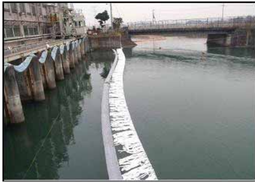
写真-5 オイルマット設置状況
