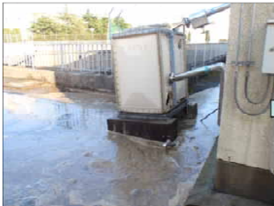
写真－３ 災害復旧の状況（揚水機も沈下した冷却タンクの原型復旧）〔東総用水施設〕
