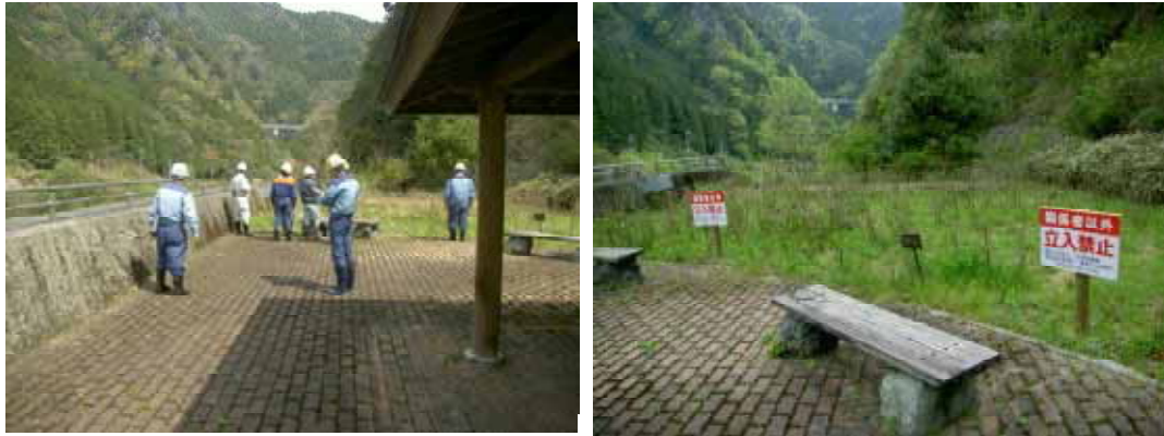
写真－１ 池田総合管理所富郷ダム
