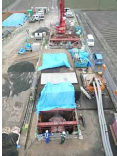
写真－5 可とう管の取替
