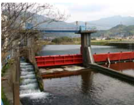
写真－６ 改築前の女男石頭首工
