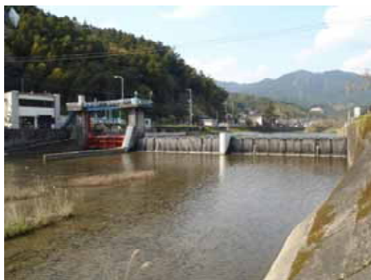
改築が完了した女男石頭首工
