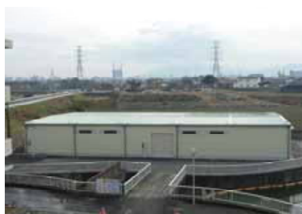
写真－５ 備蓄資機材基地（九州）
