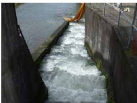
写真－８ 魚道（改築前）
