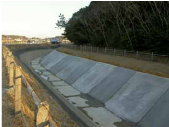
既設水路（東部幹線水路）の改築
