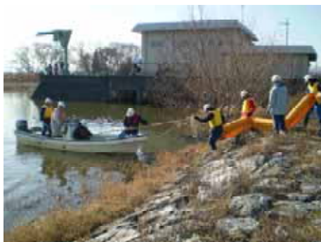
写真-7 オイルフェンス設置訓練
