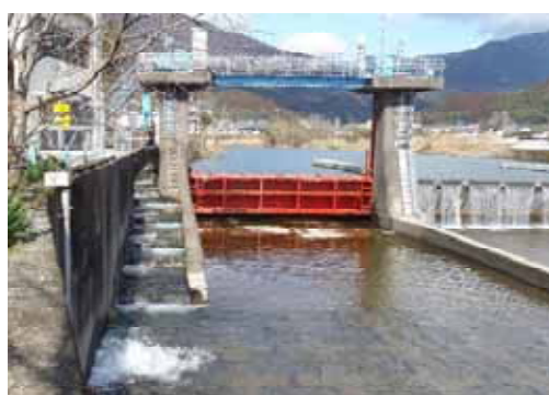
写真－７ 改築後の女男石頭首工
