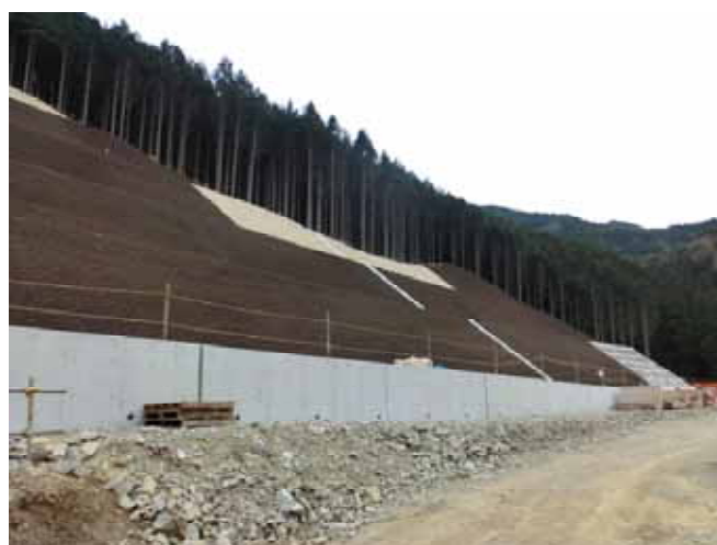
写真－4 付替国道10工区の工事状況
