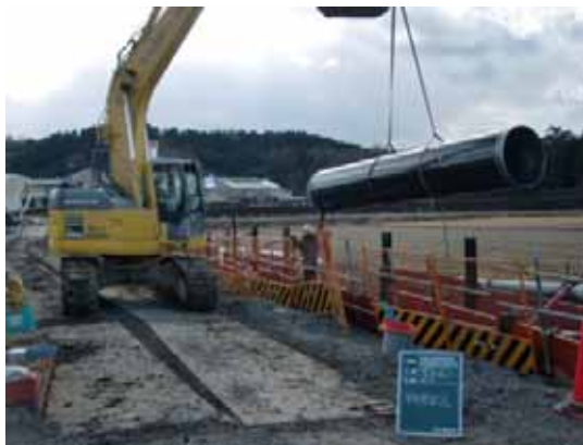
鋼管布設状況（坂祝支線水路）
