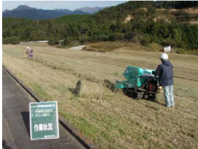
写真－３ 刈草梱包状況写真
