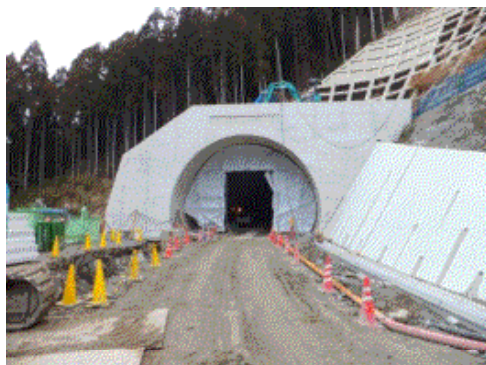
トンネル工事
