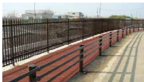
写真-2 施設整備後
