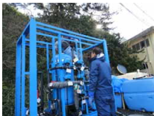
ろ過材の交換
