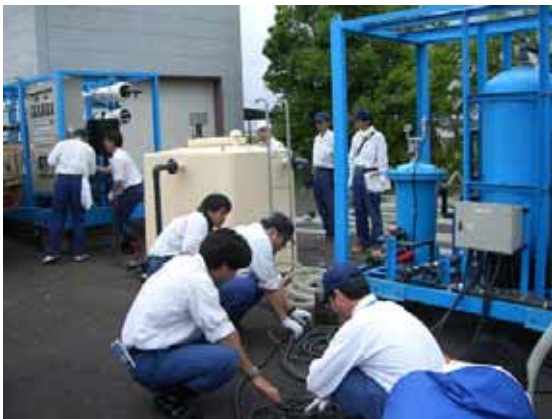
組立・解体訓練
