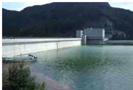
満水となった貯水池
