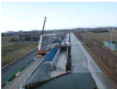
中流部改築工事状況
