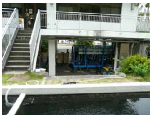
装置設置状況（扇浦浄水場）
