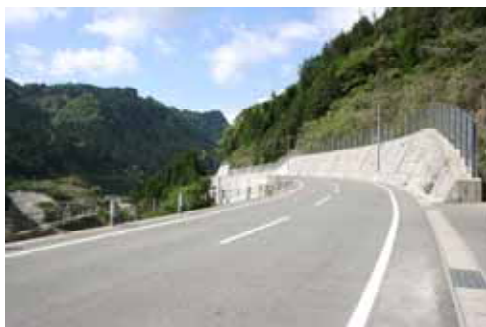
写真－１ 付替県道完成（大山ダム）
