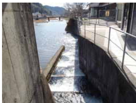
写真－９ 魚道（改築後）
