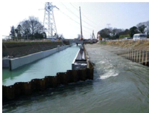
下流部改築工事状況
