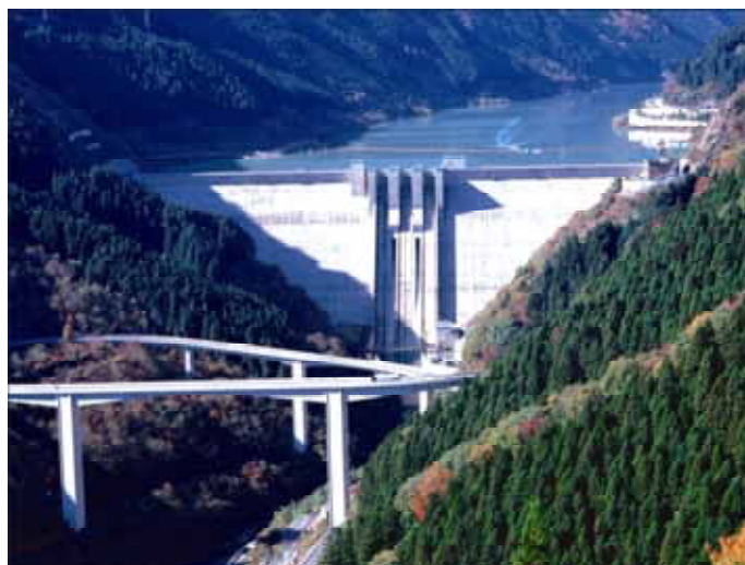
写真－1 滝沢ダム貯水池と雷電廿六木橋を下流側から望む
