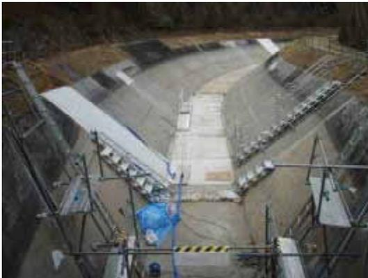
ライニングの状態に応じて、部分的なライニングの打替えや断面補修等で改築する。
