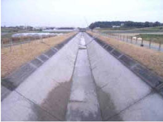
全断面を撤去し、再度ライニング水路を構築する。
