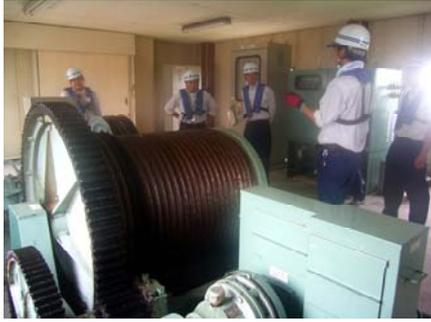
写真－6 堰ゲート機側操作訓練
