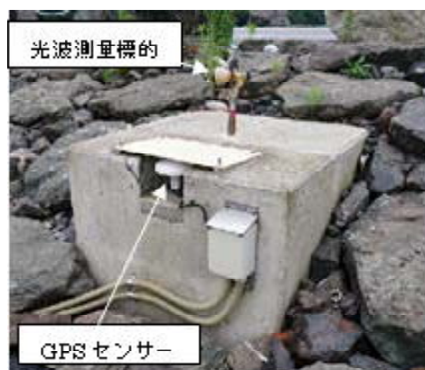
図-2 ダムへの設置事例
