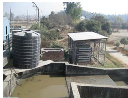
写真－5 傾斜土層法実証試験設備
