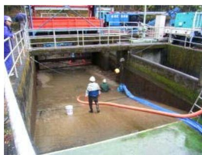
写真－3 神測量水部土砂吸引
