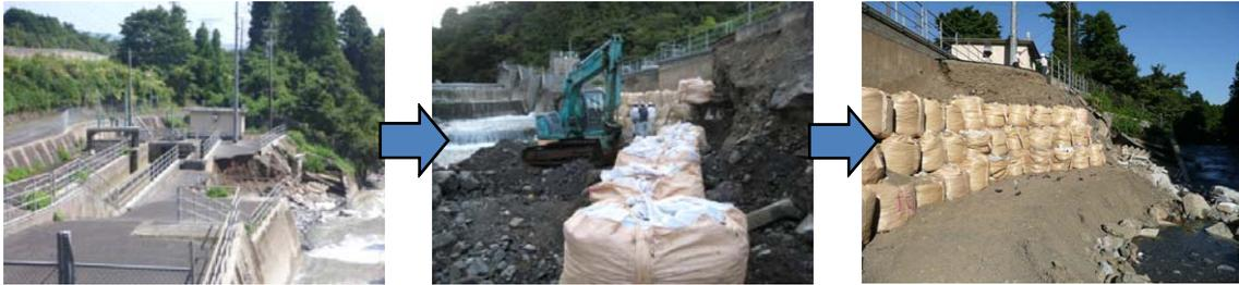
写真－１ 災害復旧の状況（河内谷川取水工護岸の応急復旧）[三重用水施設]
