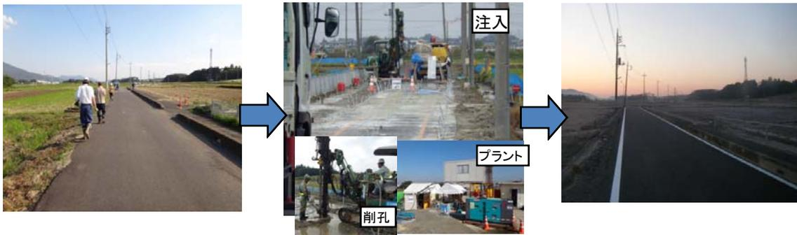
写真－２ 災害復旧の状況（地表面に変状が生じた箇所の水路効用回復）〔霞ヶ浦用水施設〕
