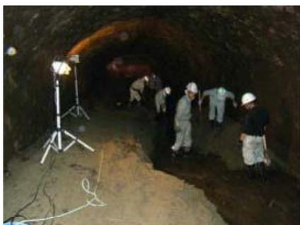
写真－2 白川取水工内土砂排除
