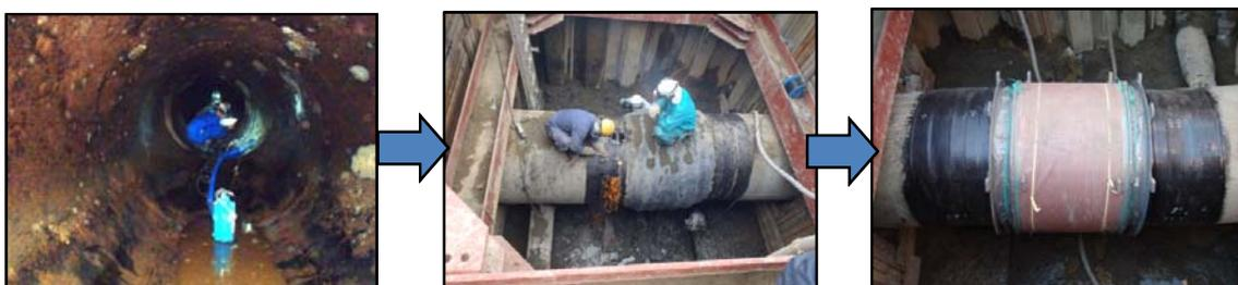
写真－４ 災害復旧の状況（許容偏心量を超過した可とう管の原形復旧）〔成田用水施設〕
