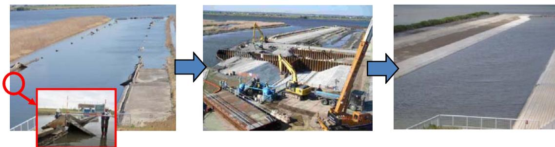
写真－５ 災害復旧の状況（取水工の沈下した開水路及び損壊した翼壁工の原形復旧）
