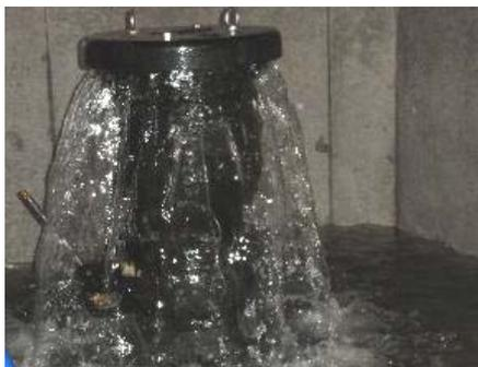
写真－2 空気弁の漏水（破損）
