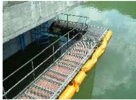
写真－４ 取水塔周りに設置した濁水防止幕（江川ダム）
