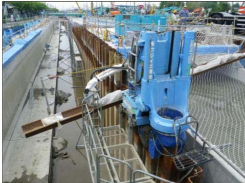
写真-9 油圧ホースの被覆状況
