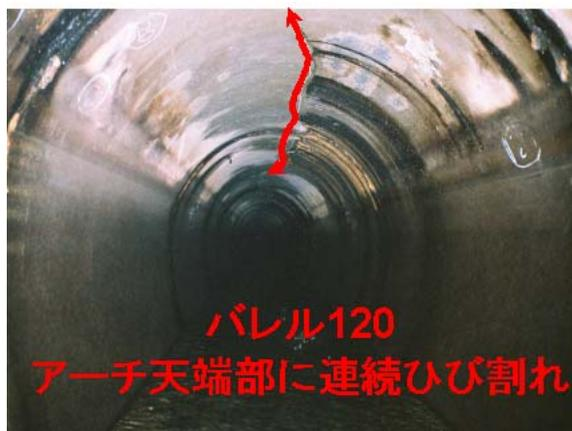
写真－1 有馬トンネルひび割れ状況
