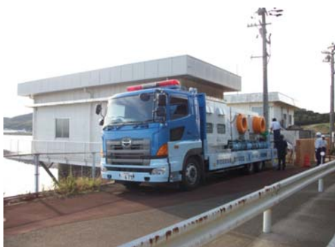
写真－1 ポンプ車配置状況
