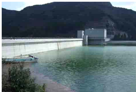
満水となったダム貯水池
