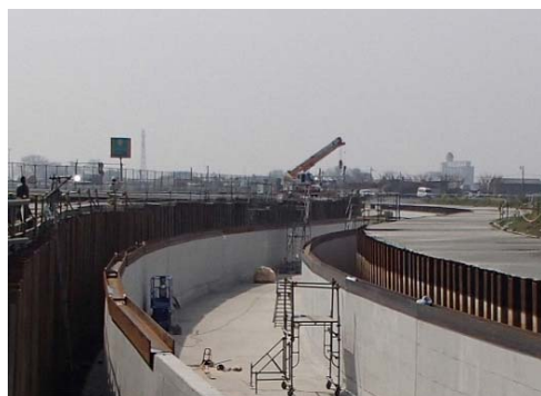
上流部改築工事状況
