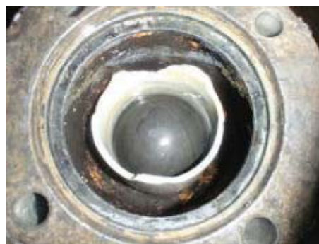
写真-16 空気弁の破損状況
