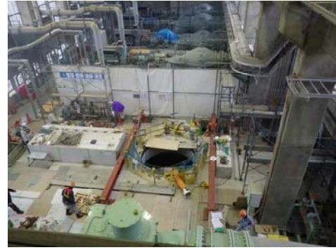
糠田排水機場工事状況
