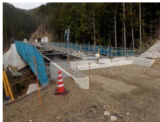
工事中の7号橋梁
