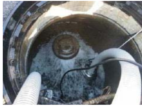
写真－２０ 空気弁からの漏水
