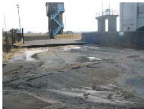
写真2 新附洲閘門機場構内 被害状況
