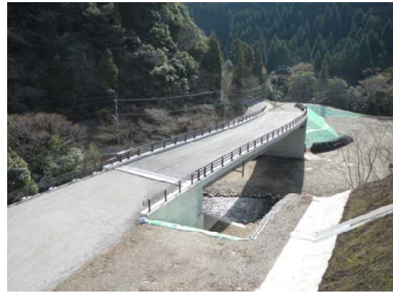
完成した「5号橋梁」
