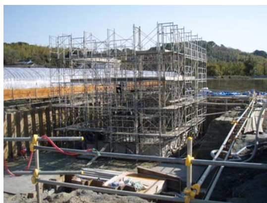
分土工改築状況 写真－7 両筑平野用水二期事業
