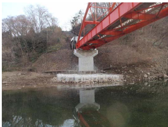
耐震補強した吾妻川水管橋
