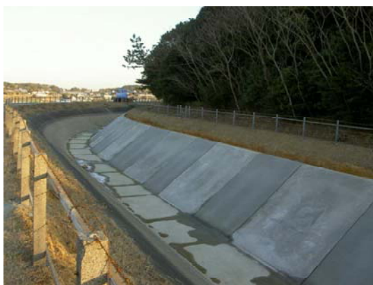
既設水路（東部幹線水路）の改築 写真－6 豊川用水二期事業
