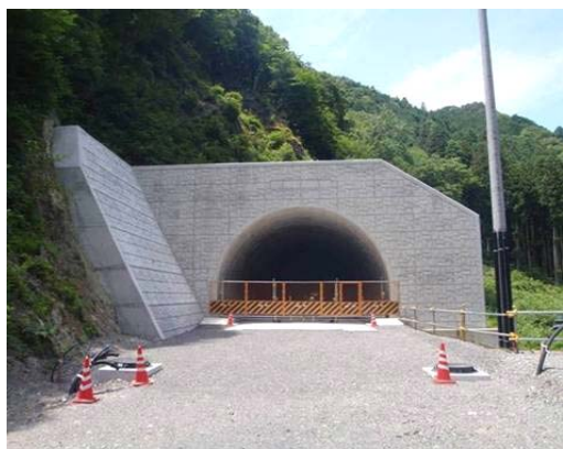
完成した1号トンネル
