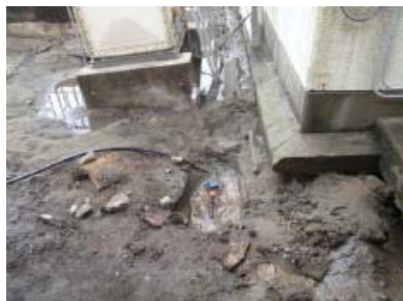
写真-14 東庄揚水機場構内液状化
