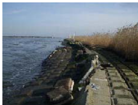
写真-4 右岸下流護岸 被害状況
