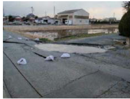
写真－10 管路上の道路陥没
