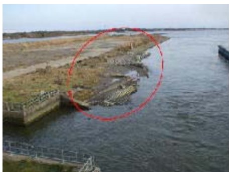
写真-3 左岸下流護岸 被害状況
