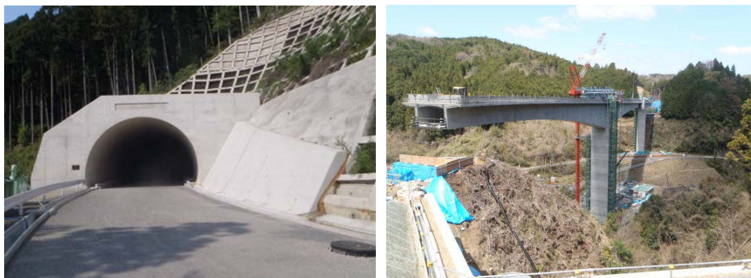
完成した「北野トンネル」
