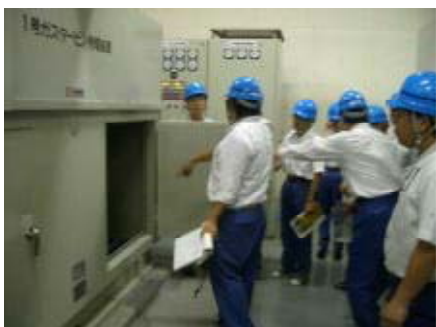
写真-3 予備発電機運転訓練
