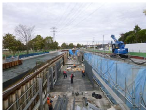
中流部改築工事状況
