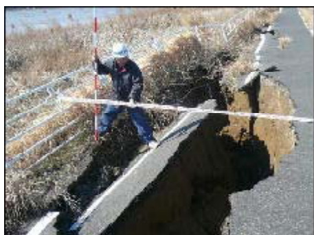
写真-5 堤防被災状況
