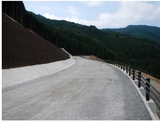
完成した「10工区」
