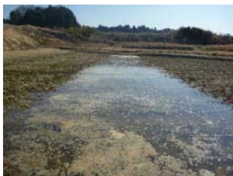
写真-17 北部幹線バイパス水路の漏水
