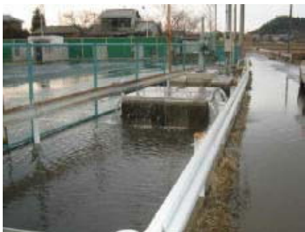
写真－11 分水工からの漏水と道路の冠水
