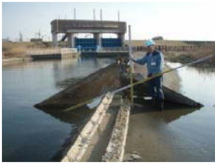
写真－9 取水口開水路破損
