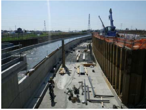
下流部改築工事状況
