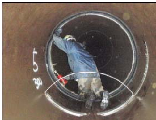
写真-3 管水路漏水補修状況
