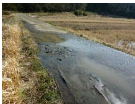
写真-18 北部幹線バイパス水路の漏水
