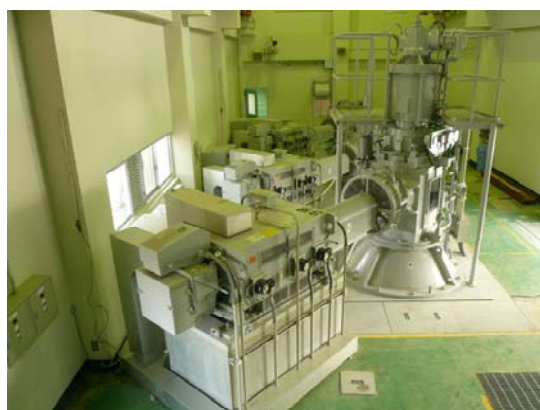
改築したポンプ設備（酒直機場）
