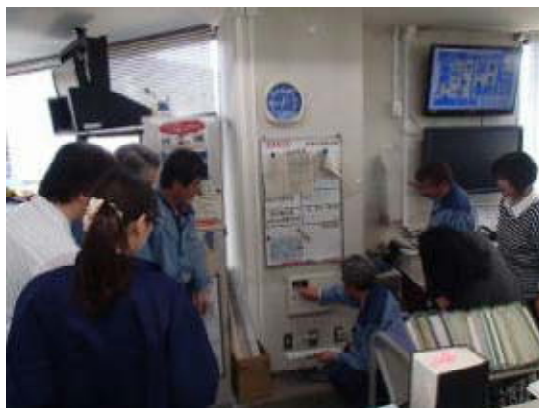
写真－１０ 非常通報装置の説明・確認作業
