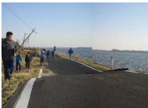
写真1 北浦左岸16.5k湖岸堤 被害状況
