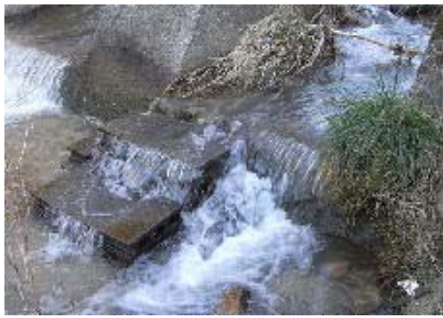
写真－7 オオサンショウウオ道 (ブロック積み型)
