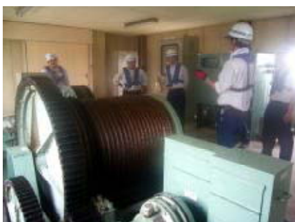
写真-5 堰ゲート機側操作訓練
