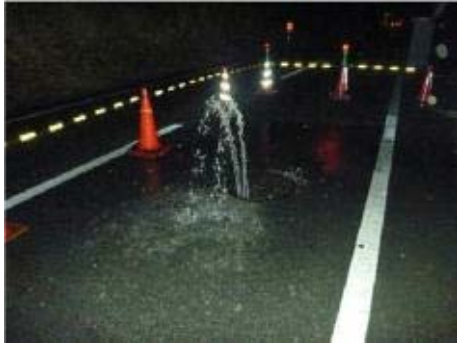
写真－１９ 空気弁からの漏水
