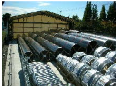
写真-6 備蓄資材 (利根導水)
