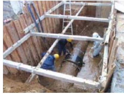
写真－8 漏水補修状況
