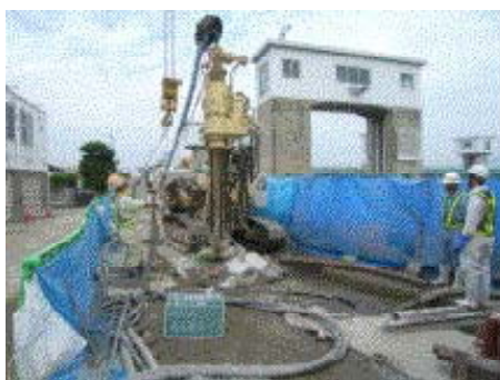
写真－1 耐震補強工事の状況
