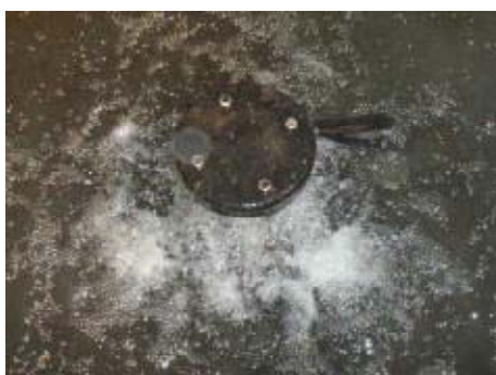
写真-15 空気弁からの漏水
