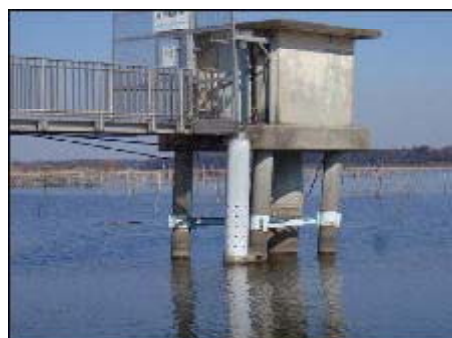
写真-6 水位計局舎傾斜の状況
