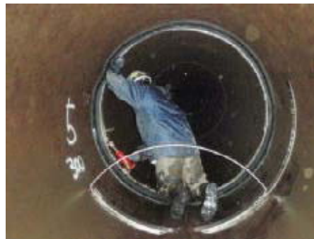
写真－12 幹線水路漏水補修状況
