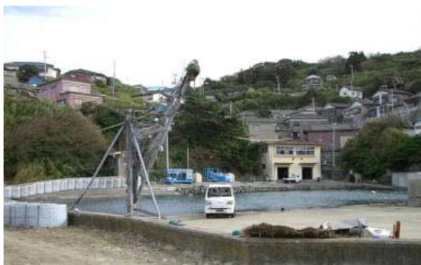
女川町給水支援（全景）
