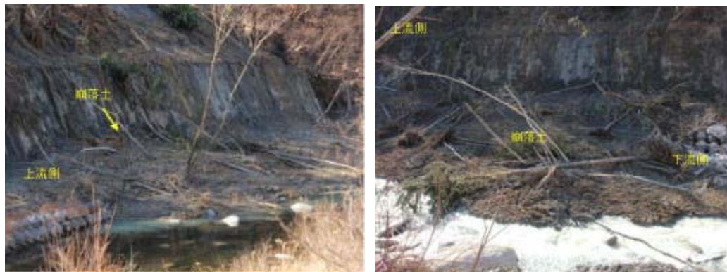
写真－２１ 源五郎沢堆積場付近の土砂崩落状況
