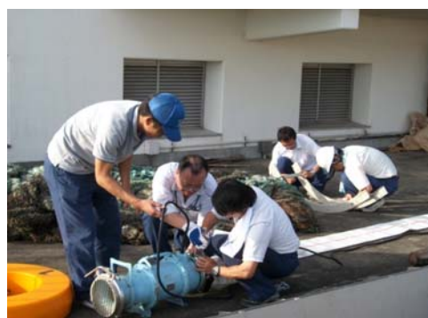
写真－2 ポンプ設置状況
