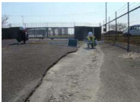
写真-13 笹川取水口敷地内液状化
