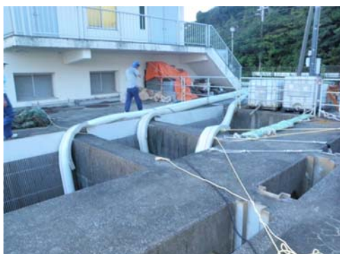
写真－3 配管状況（給水槽側）
