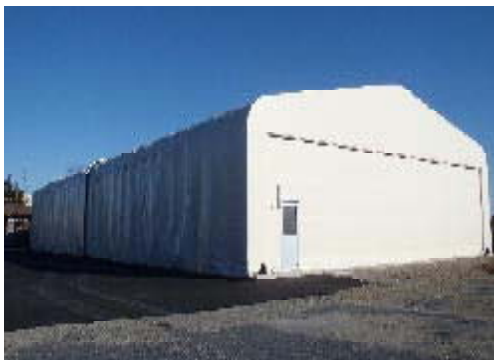
写真-5 備蓄資材倉庫 (利根導水)
