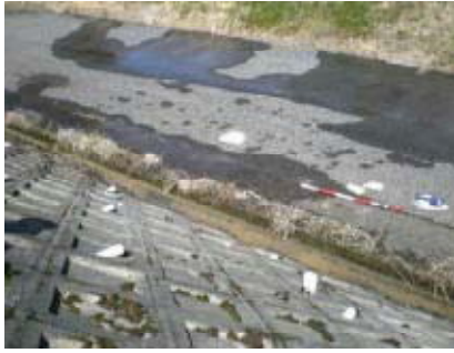
写真－7 小泉機场内バイパス水路漏水
